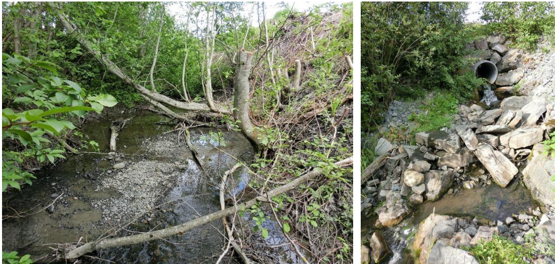
Figur 21. Stasjon 3 (bilde til venstre) og kulvert (bilde til høyre) under fylkesveg i Follobekken. Foto: Sivert Dahlen Lund.
