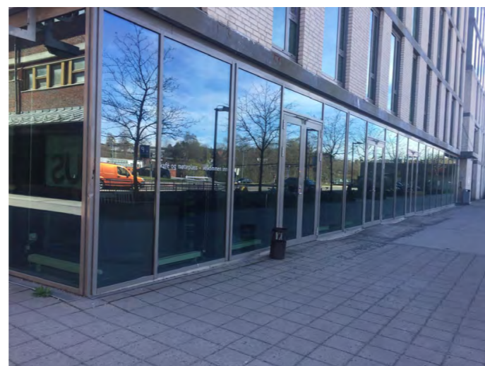
Figur 58 - Utearealene og fasaden inn mot innbyggertorgetts kaféområde. (Foto: privat).
