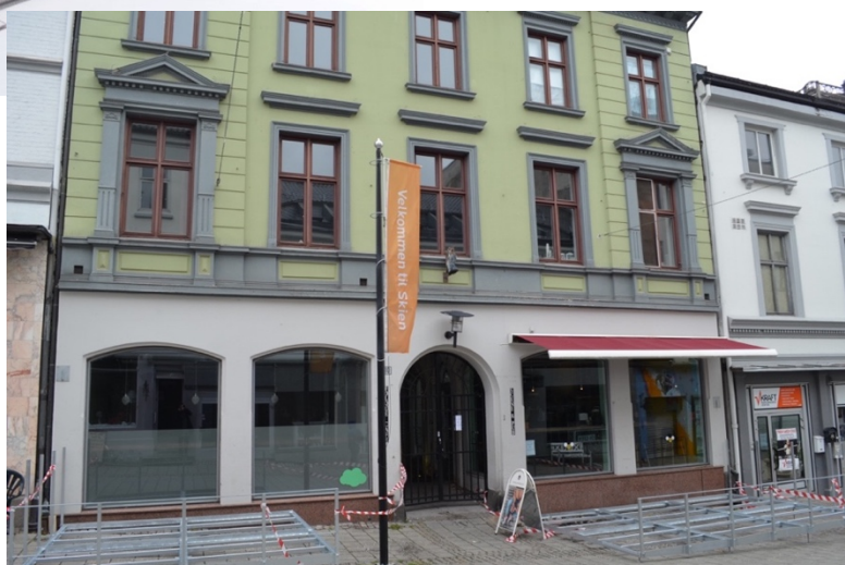
Figur 24: Bildet viser påbegynt arbeid for uteservering innenfor casets som følger veileder for uteservering (Telnes & Kragset 2017).
