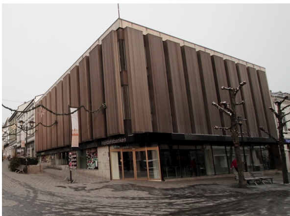
Figur 17: Bilde av Telemarksgata 10 før opprustningen.
