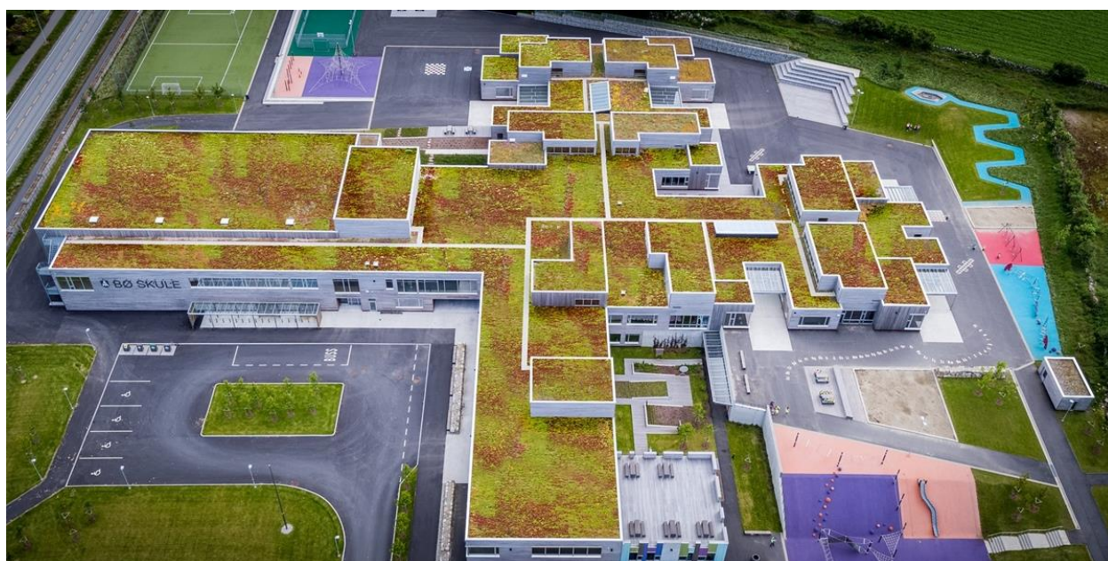
Figur 2.2: Grønne tak som et tiltak for mindre nedbørshendelser (BERGKNAPP AS, 2020).
