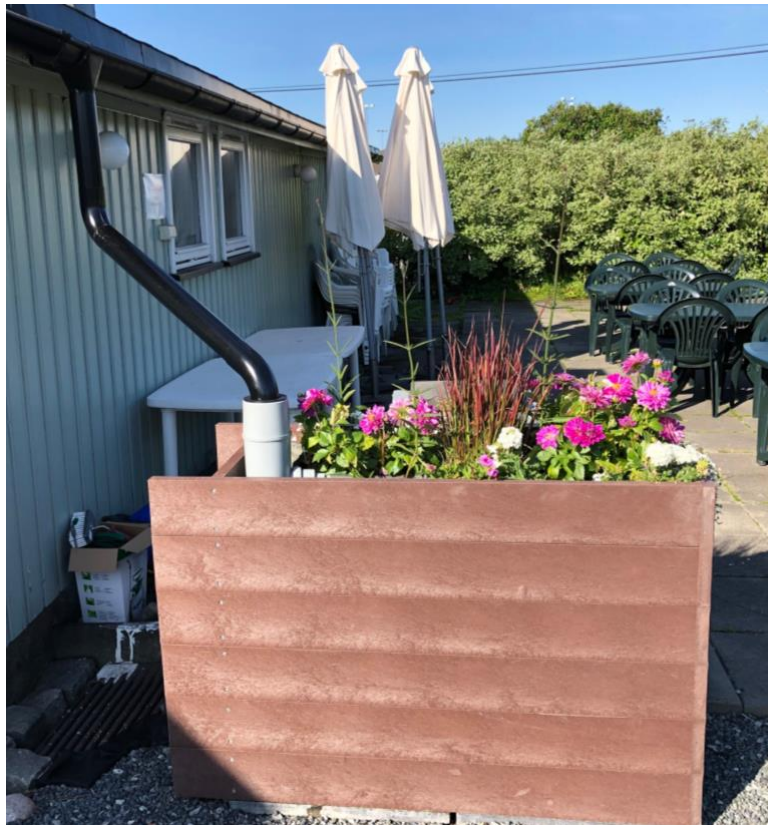
Figur 1.5: Miniregnbed ved Sogn hagekoloni tilkoblet tak gjennom taknedløp og vannføringsplitter. Foto: Bent C. Braskerud.
