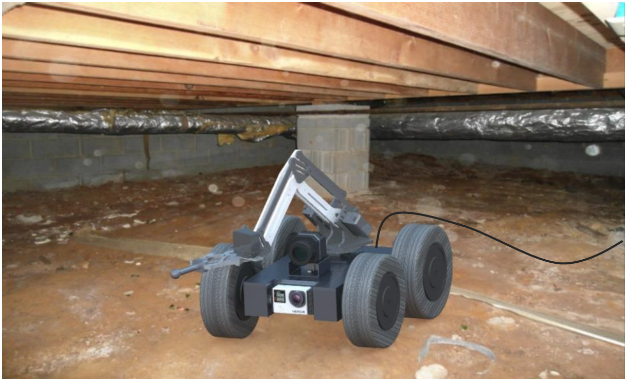
Figur 8.3: Inspeksjonsroboten på oppdrag i et potensielt arbeidsområde.
