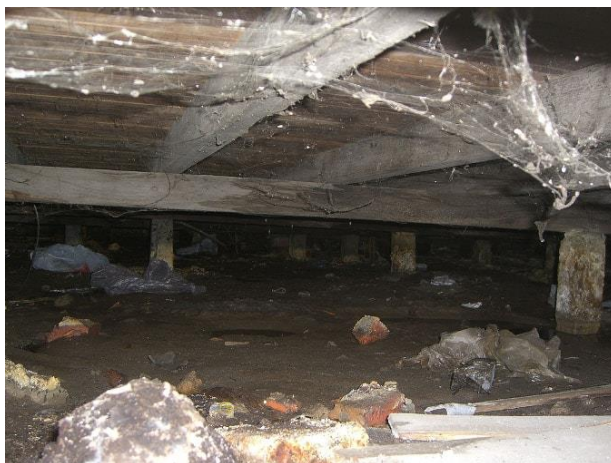
Figur 4.9: Et typisk kryperom. Takhøyden er lav, ujevnt underlag og forekomster av stein og andre gjenstander [37].
