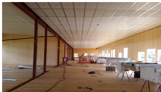
Figur 28: Massivtredekke under konstruksjon (Korbøl, K. A - ØMFjeld).
