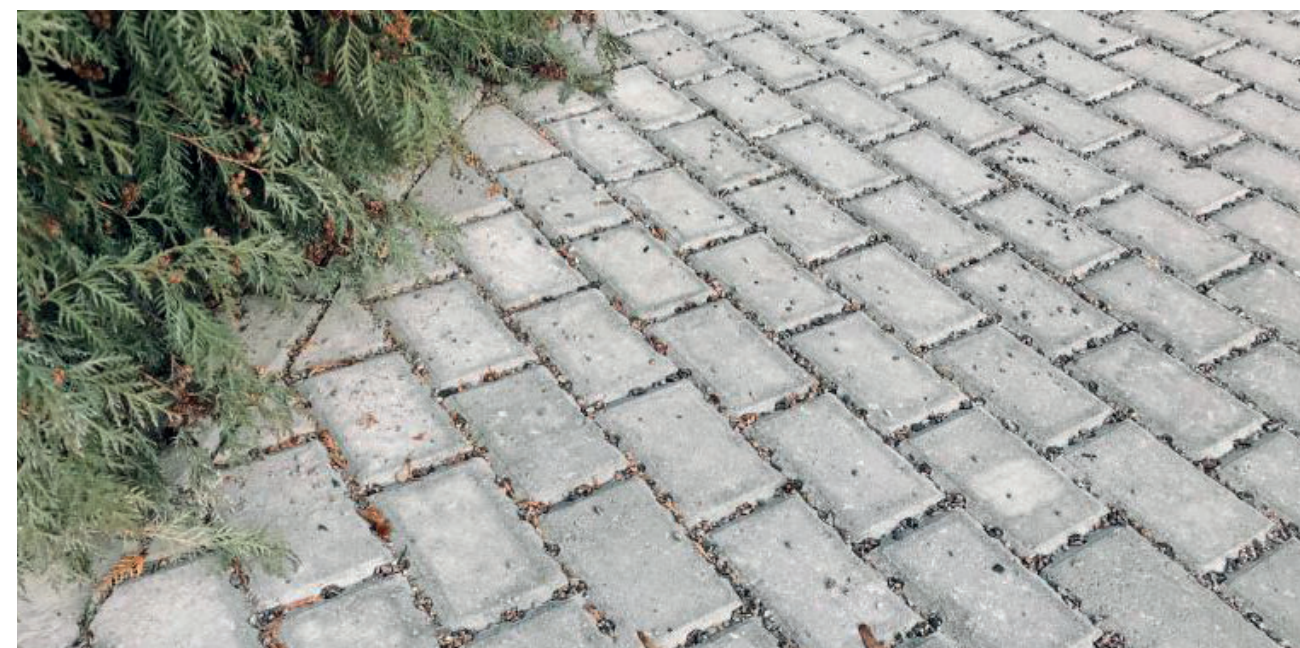
Foto 6.4 Belegningsstein med permeable fuger. Foto: Aaltvedt, u.å.
