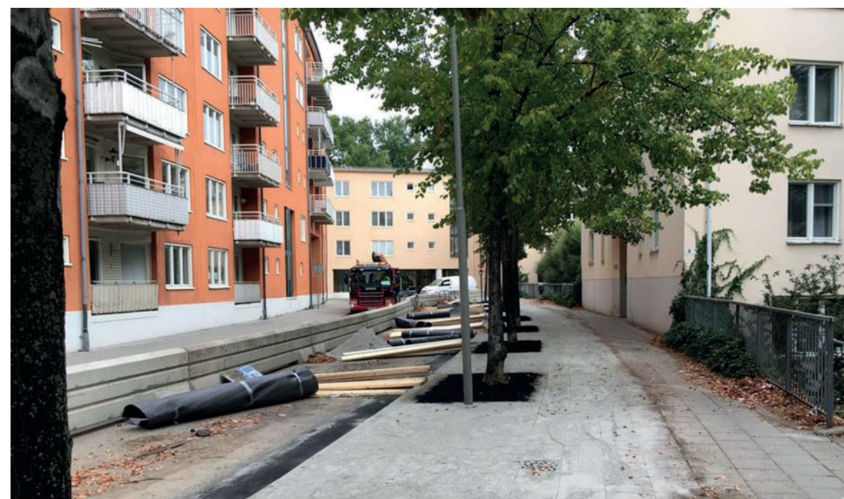
Foto 6.10 Stockholm Stad benytter biokull i byens plantebed, her i Bo Bergmans Gata. Foto: Stockholm Stad (2020)
