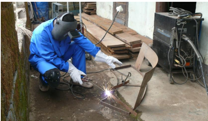
Figur 1.6: Sveising av setet til krakk
