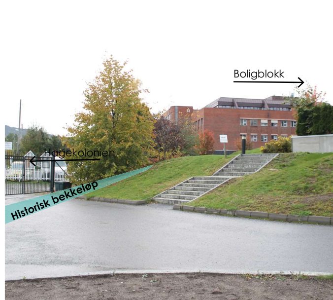
STREKNING E: Hagekolonien grenser til grøntarealet som tilhører boligblokken langs strekning E (skiltet PRIVAT). Det historiske bekkeløpet går langs strekning E.
