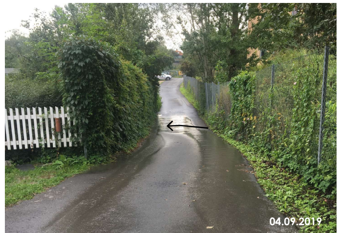
9. Vannet renner ned til det laveste punktet som ligger på hyttetomtene bak gjerdet. (Foto: Line J. Barkved)
