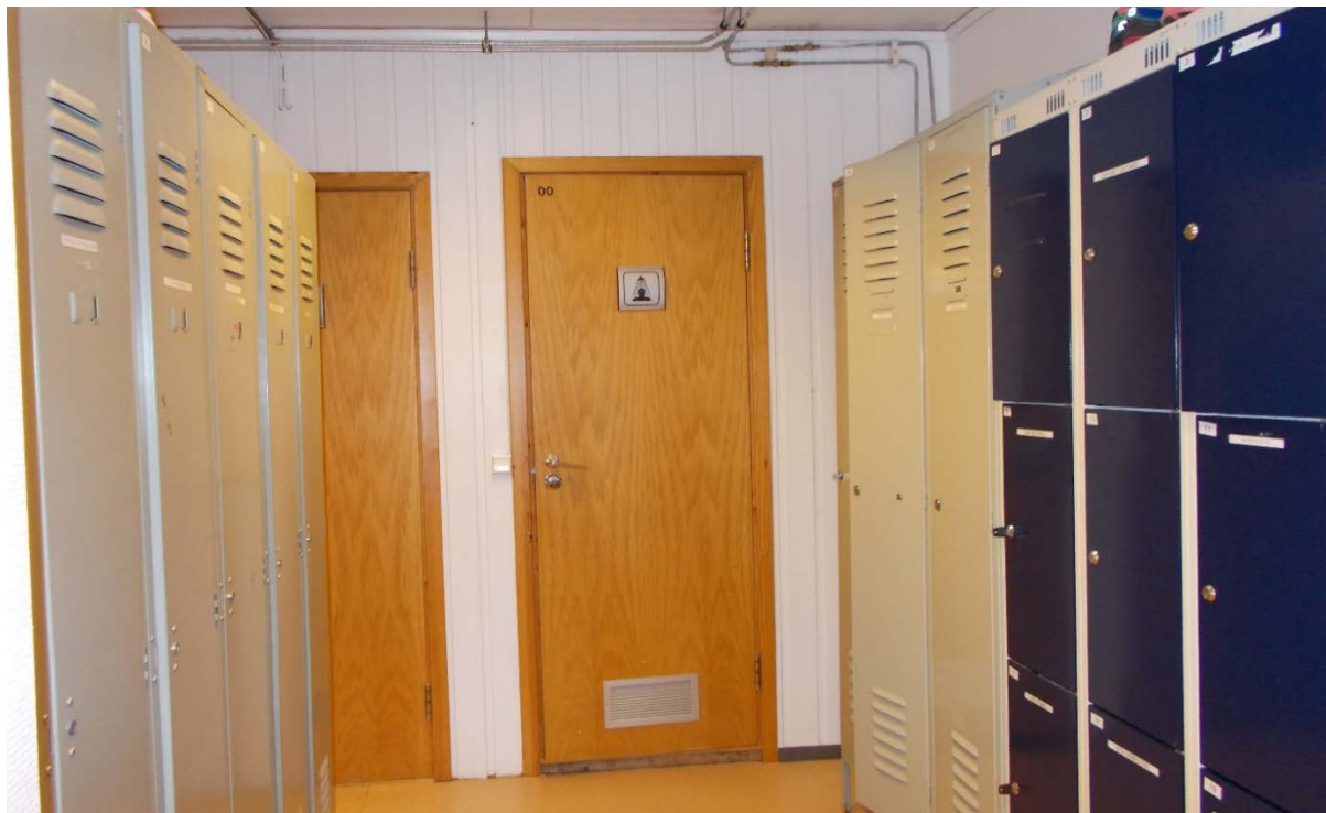
Foto 9 Synlig tre i dører og dørkarmar, garderobe, Aure sjukeheim.
