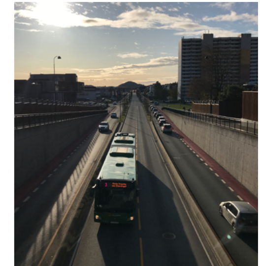
Ferdig bygget strekning med eget tunneløp for buss (Foto: Hans Christian Egeland, 2019)
