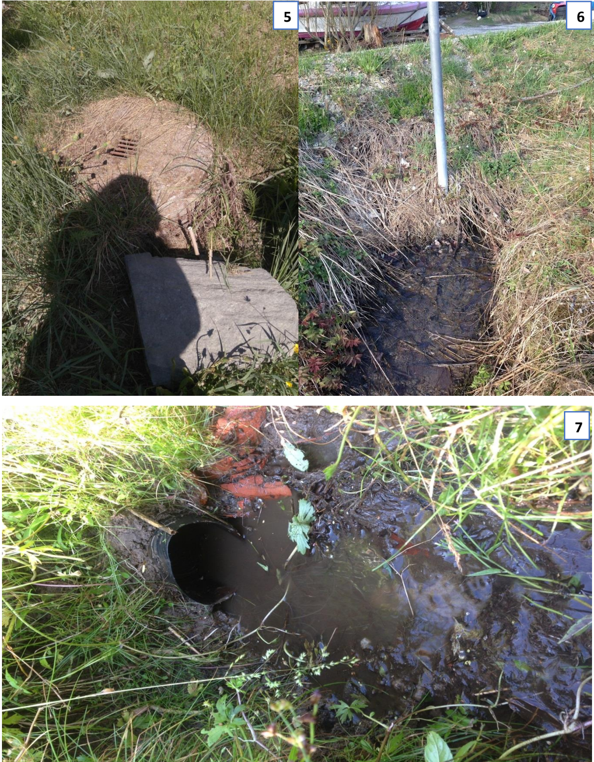
Figur 12. Oversikt over bilder ble tatt av høydeforskjellen mellom hovedveien og grøften (bilde 1), åpen grøft (bilder 2,4 og 6), overvann (bilde 3), felles betongkum som leder avløpsvannet til grøften (bilde 5), utslippsrør fra felles betongkum (bilde 6) og inntaksrør som fanger opp avløpsvann fra grøften (bilde 7).
