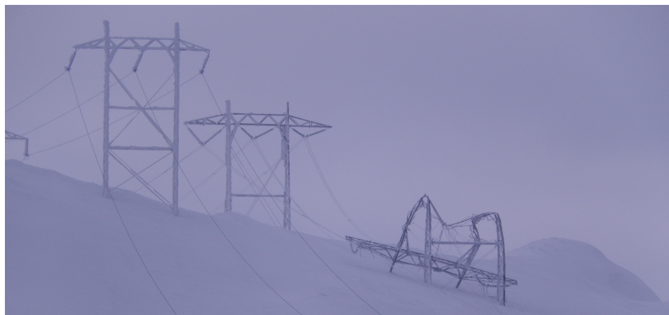
Figur 1.2: Mastehavari mellom Kvilldal og Rjukan i 2014. Foto: Statnett
