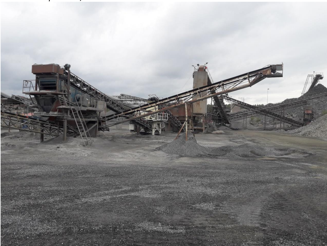
Bilde 3: Produksjonsutstyr i Moss pukkverk, sommeren 2018. Stenmjøl blir et biprodukt i denne produksjonen.
