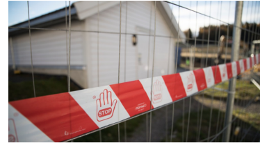
Ekspllosjonsfarlige nivåer i boden – ber kommunen kjøpe opp boliger
