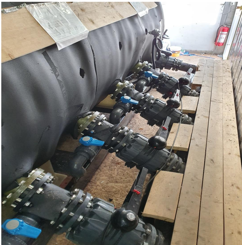
Bilde 4. Reaktorvegg med kraner for uttak av substrat
