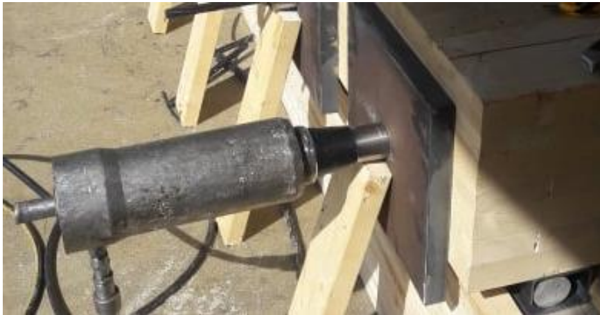
Figur 57: Bilde av den hydrauliske jekken tatt mens den spenner opp en av kablene i 7-lags elementet.
