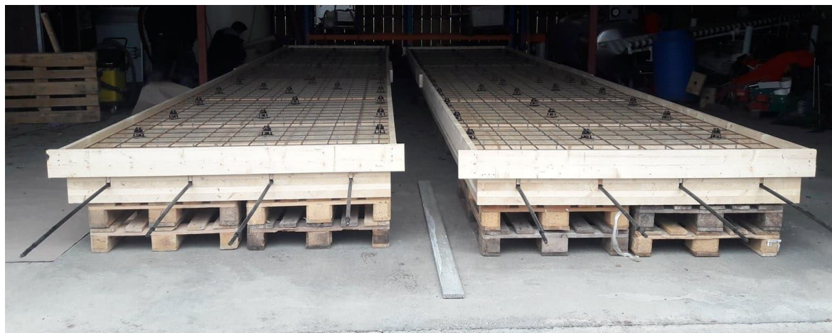
Figur 54: Bilde av de to samvirkeelementene med forskaling klare til støp.
