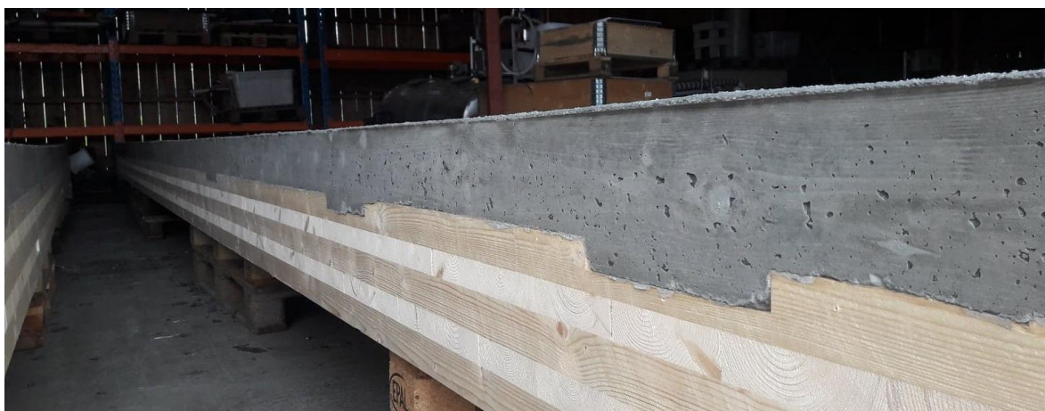
Figur 45: Bilde av skjærsporene i ett av de to samvirkeelementene.
