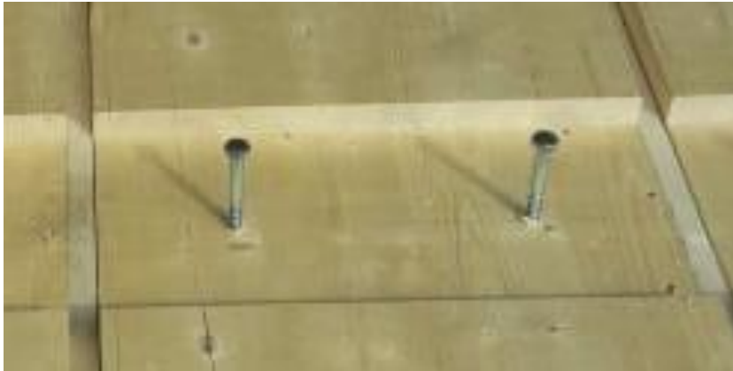
Figur 55: Bilde av plankebitene som ble lagt i sporene oppå kablene.
