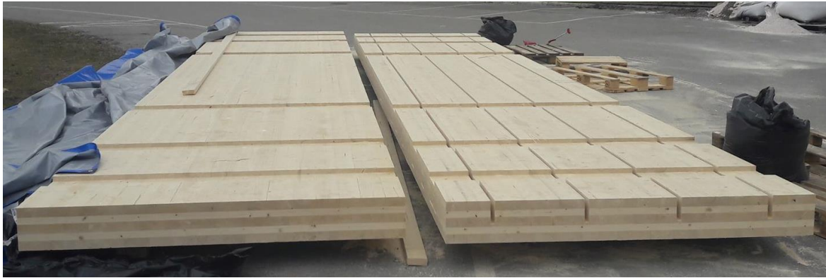
Figur 46: Bilde av de to 5-lags massivtreelementene. Tv. elementene slik det ble levert fra produsent, th. Elementene etter at spor til kabler er tatt ut.
