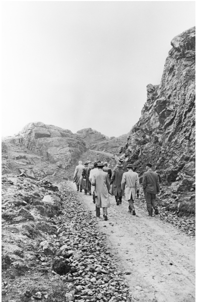
Foto: Ukjent, SSF. Frå 1960. Vegen mellom Hop-Hardbakke.
