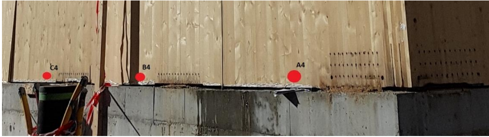
Figur 24 Målepunkt på ytterveggen i plan 1
