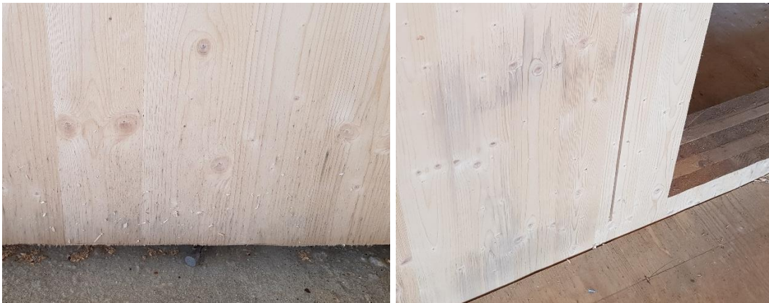
Figur 51 Påbegynt muggvekst på massivtreelement i plan 1 (venstre) og på utsida av teknisk rom og dekke (høgre). Fotografert 1. april
