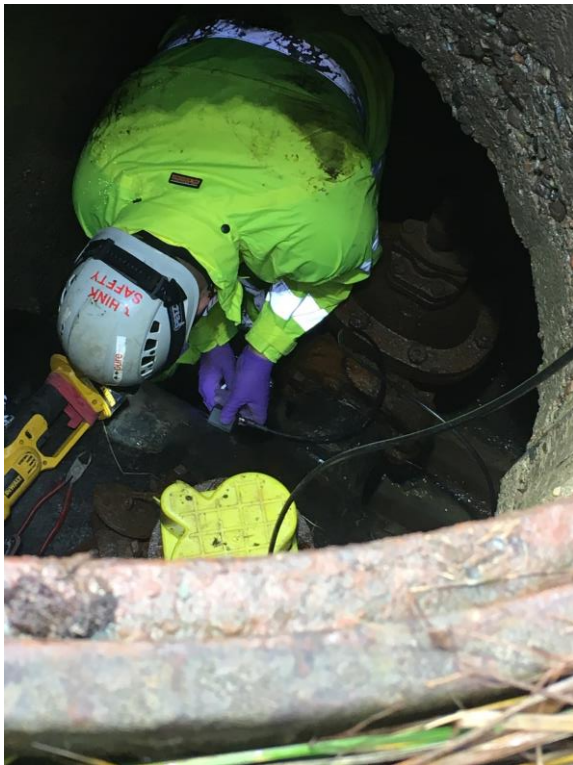
Figur 13: Bilde av sensoren, bilde som viser festing av sensor på røret. Kilde: Helene Olsbye
