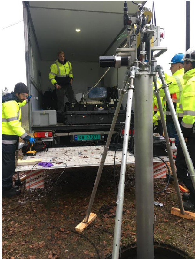
Figur 21: Installasjonen av Sahara er ferdig. Bilde av innsiden av røret kan ses i bakgrunnen.
