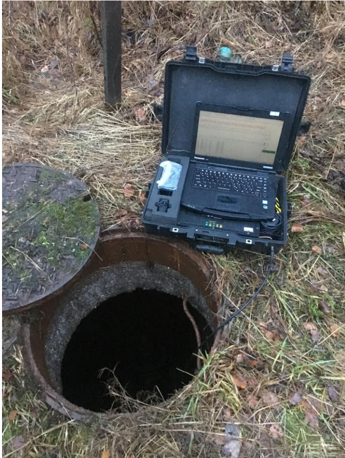
Figur 17: Bilde som viser pcen koblet til sensoren under inspeksjonen. Kilde: Helene Olsbye
