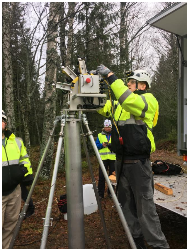
Figur 20: Etter Sahara var i røret, monterte man på et instrument som sørget for jevn innføring av kabel til Sahara.
