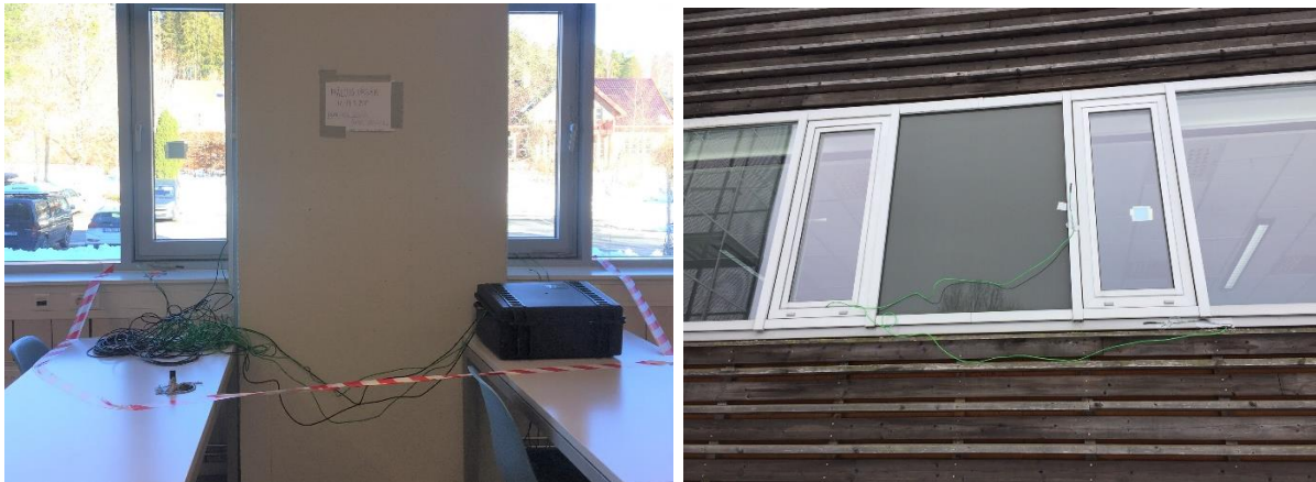
Figur 18 Innvendig og utvendig oppmontert feltarbeid på Sørhellinga. Målingene blir utført på vinduet til venstre sett innenfra, mens utvendig termoelement er dratt gjennom det høyre vinduet.
