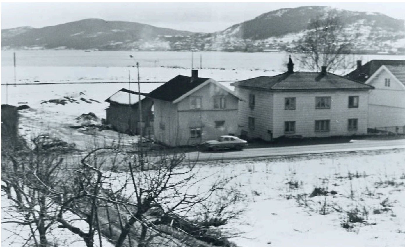
Figur 3.9: Bildet viser Gamleskolen som ble tatt i bruk frem til 1920. I bakgrunnen ser man Drammensfjorden.
