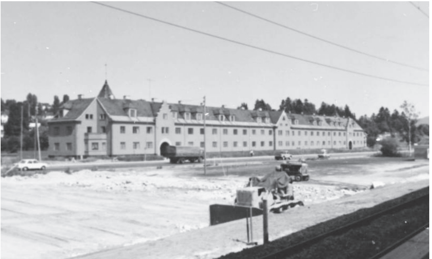
Figur 3.11. Bildet viser National industriens arbeidsbolig. Bygget ble revet da den nye motorvegbroa kom.
