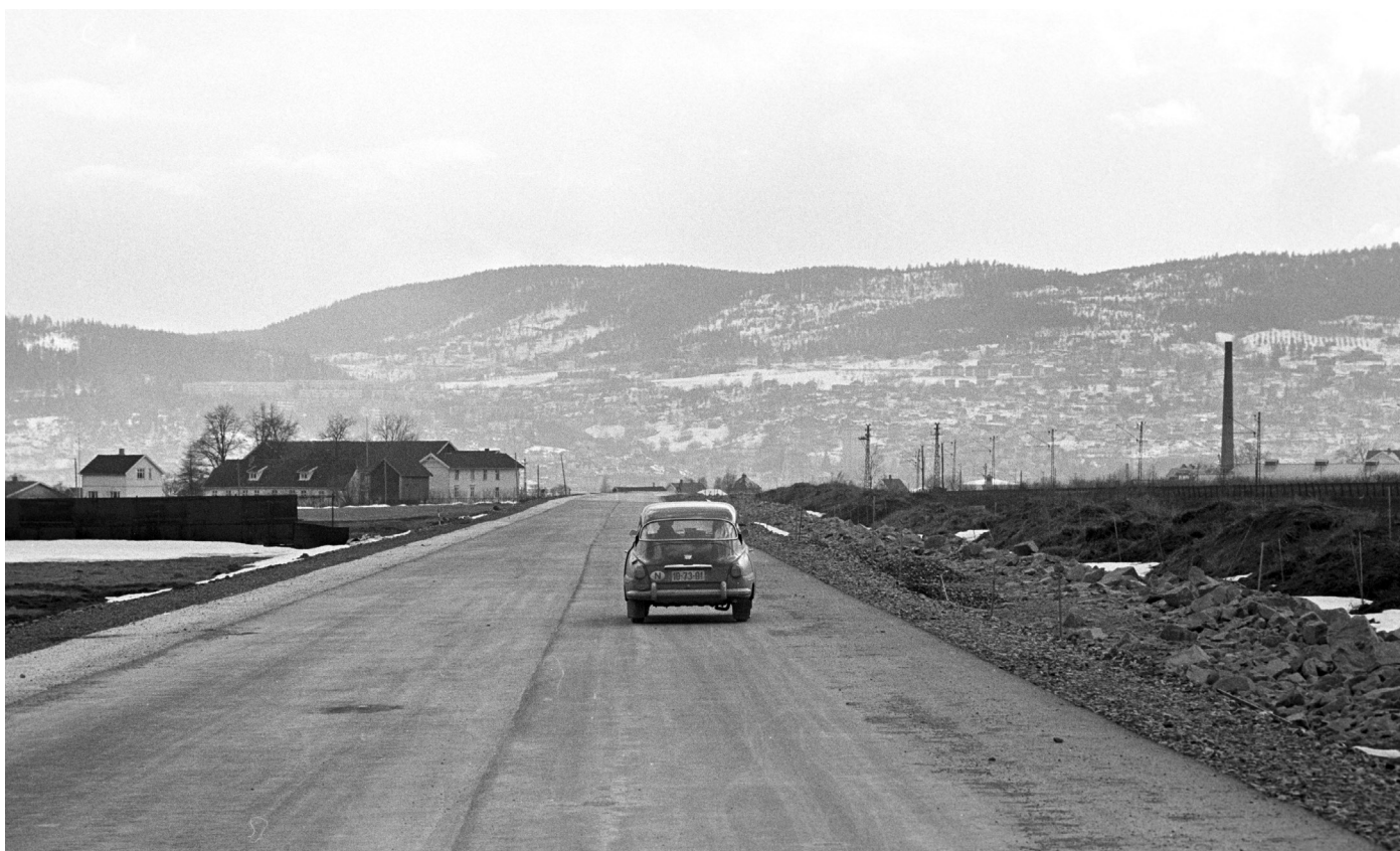
Figur 3.10: Bildet viser den nye motorveien, med jernbanetrase til høyre i bildet. Bildet ble tatt august 1969.
