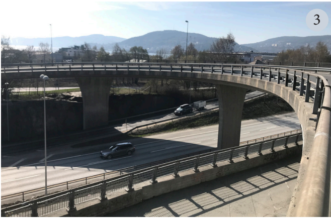
Figur 4.15: Overgang over E18.
