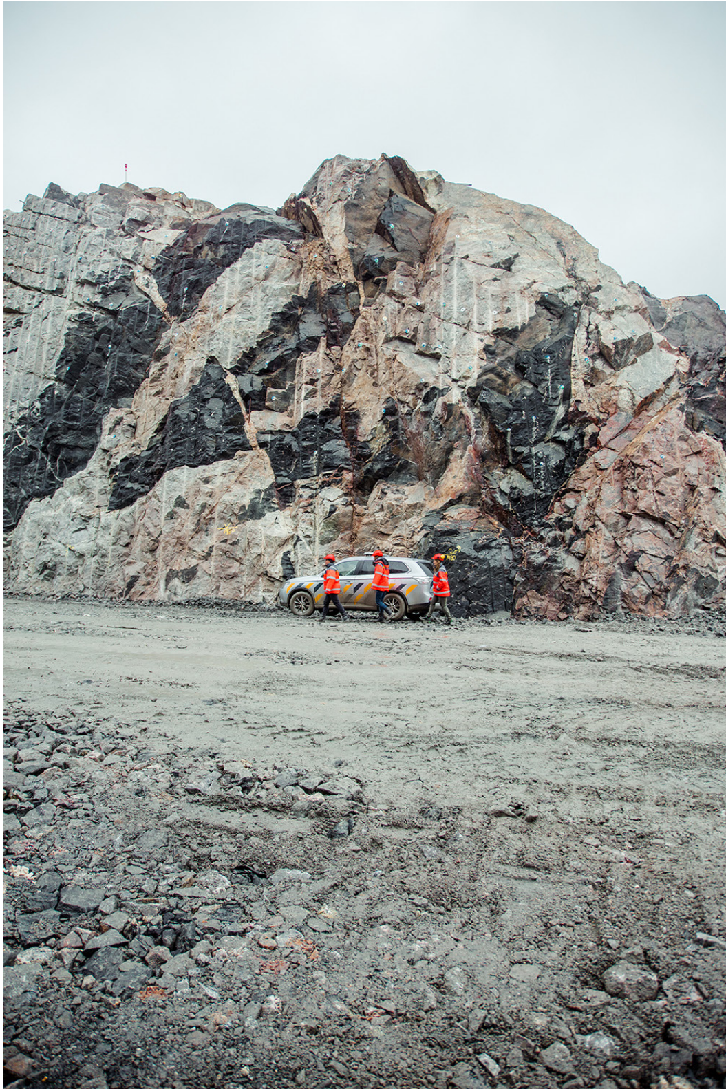
Figur 2.1 Skjæring i fjellet i forbindelse med bygging av E18 Knapstad-Retvet.
