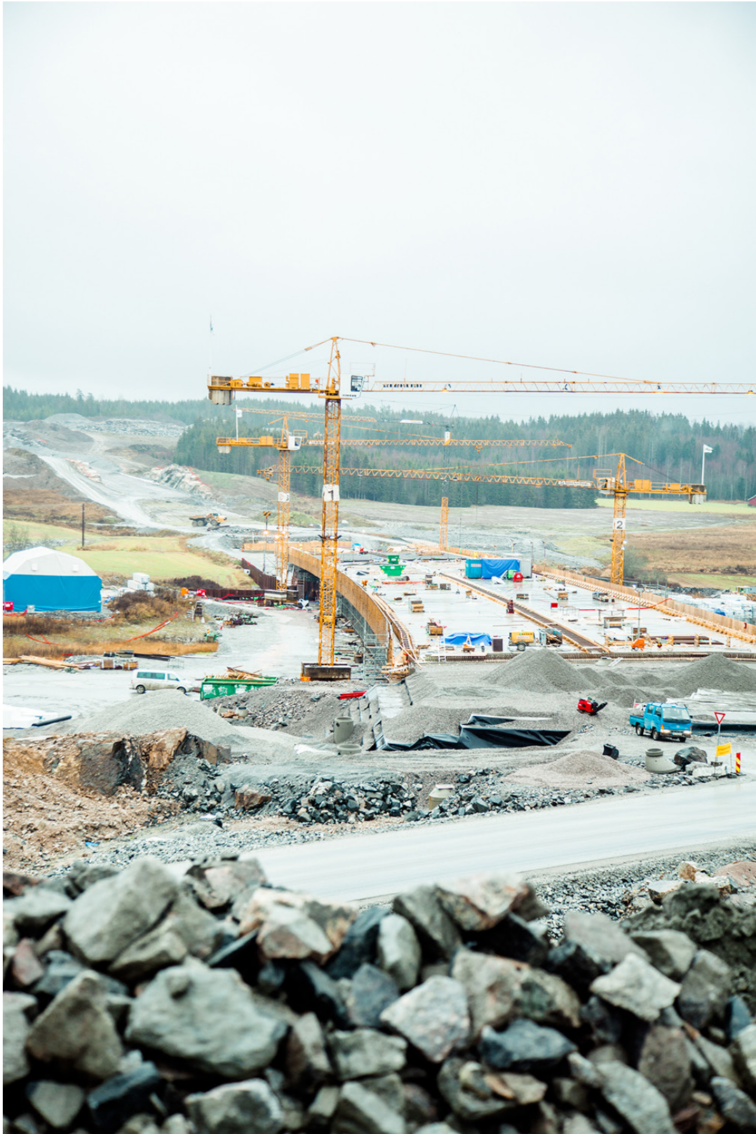
Figur 1.1 E18 Knapstad-Retvet under oppføring ved Elvestad, 2015.
