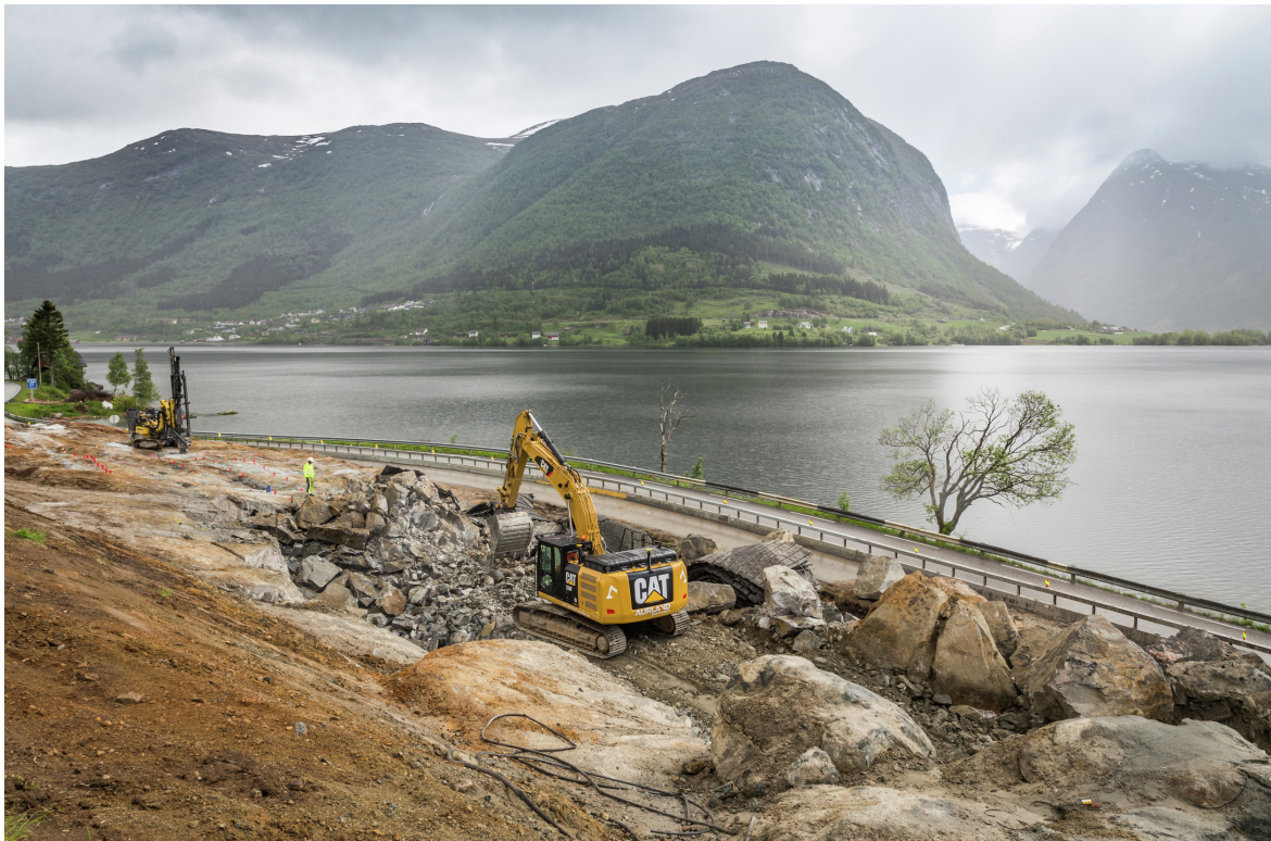
Figur 3.1 E39 Bjørset-Skei i Jølster, 2017. Bergrensk og sprenging.
