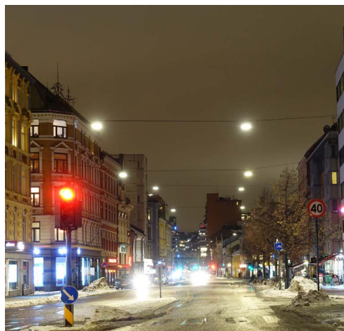
Vaierstrekkbelysning over gateløpet
