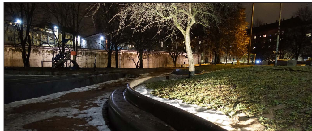
En noe sterkere spotlight av typen 'Dart medium' peker bortover langs bakken inntill benkens rygg, og framhever både vegetasjonen bak benkekonstruksjonen og benken i seg selv som en negativ kontrast.
