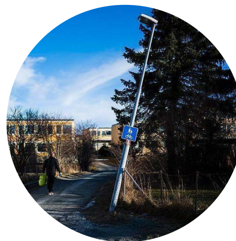
FIGUR 156: Skjeve master ødelegger for optisk føring og gir rotete anlegg med dårlig koherens. (Old, 2015)
