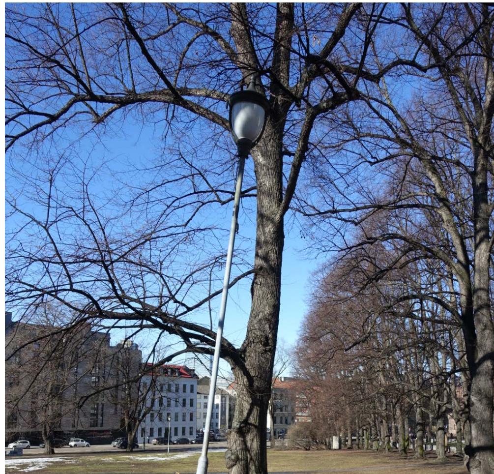
Skjev mast med den tradisjonelle 'oslolamapa' montert på toppen.
