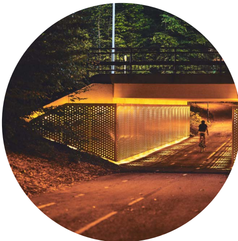
FIGUR 108: Lysinstallasjonen 'Beehive' bruker indirekte belysning for å hindre blending og oppnå mykere overgang mellom ulike lysnivå (Lightingmetropolis, 2017)
