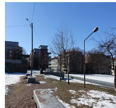
Belysningen til fotballbanen på tremast t.v. Mast og armatur med udefinert funksjon t.h
