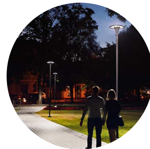
FIGUR 107: Parkarmaturer montert på mast (Glamox, u.å)
