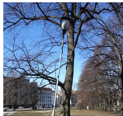
Skjeve mast med Oslolampe-armatur
