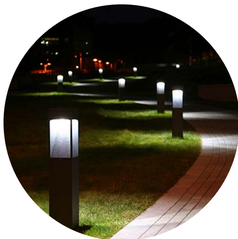
FIGUR 117: Pullertene følger gangstien og viser hvor veien leder. For best optisk føring monteres de konsekvent på samme siden av stien (Glamox, u.å)
