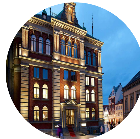
FIGUR 197: Den nye fasadebelysningen på Bergen Børs Hotell gjør at bygget trer fram i stedet snattidentitet (Zenisk, u.å)
