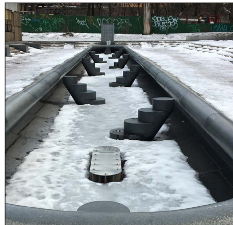
Foto av overvannsbassenget fra befaring på dagtid
