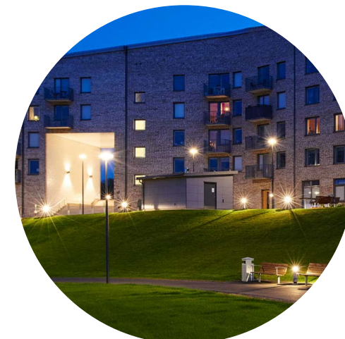
FIGUR 90: God allmennbelysning som synliggjørgangstien og øvrige omgivelser, og gir strølys til de omkringliggende flatene med flatt dekke. (Fagerhult, u.å)
