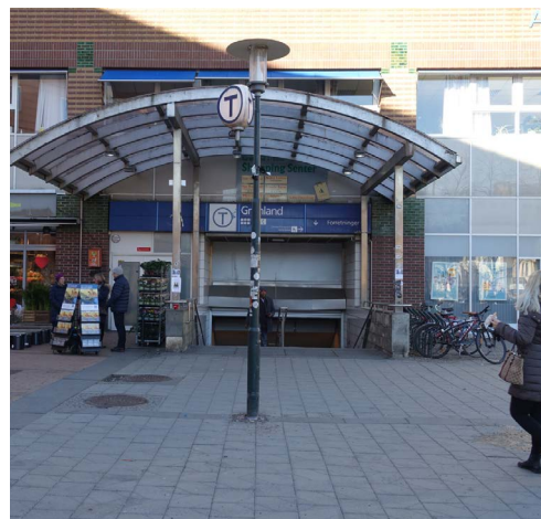
Mast- og armaturtype på plassen
