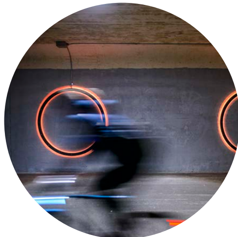
FIGUR 163: Dynamisk lys på sykkelstien i Famuruten i Danmark som registrerer forbipasserende syklister og gjengir bevegelsesretningen i hjulene på veggen (Ankerstjerne, 2018)
