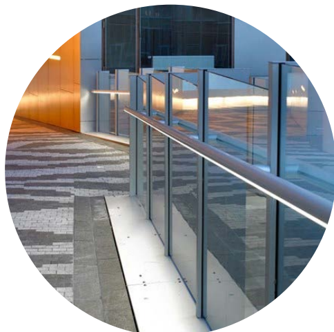
FIGUR 120: Kanten avgrenses og synliggjøres tydelig ved bruk av innfelt lys langs rekkverket (Fagerhult, u.å)
