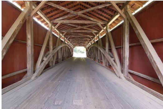
Figur A-13: Burr system, Baumgardener overbygd bru i USA[11]
