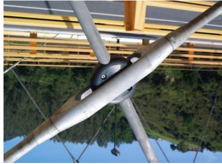
Figur 3-4: Festløsning mellom hengestag[7]
