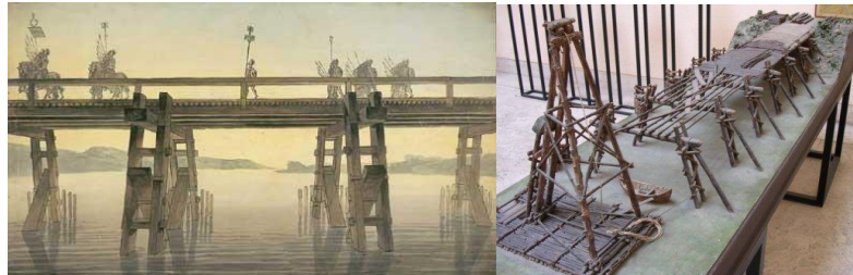
Figur A-2: a) Julius Cæsars bjelkebru over elven Rhinen. b) Bjelkebruen i Nasjonalmuseet i Roma[4]
