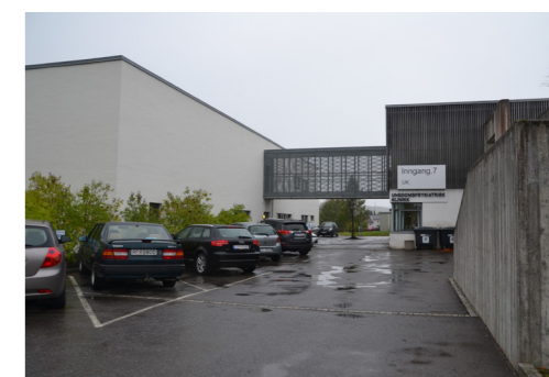
Fig. 3.15 Inngangsparti med harde flater
