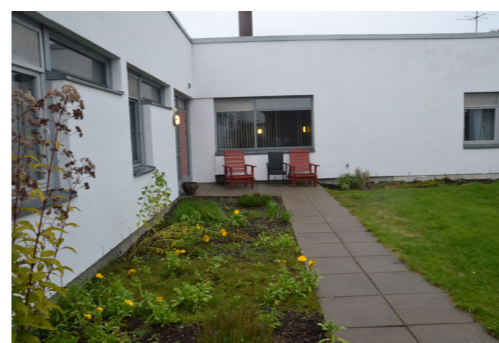
Fig. 3.10 Hvit murvegg og betongheller
