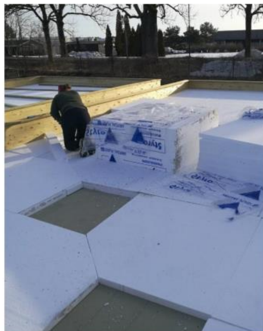
Figur 19: Fallplatene kuttes for å tilpasse konstruksjonen(Øyre & Trommald, 2018)
