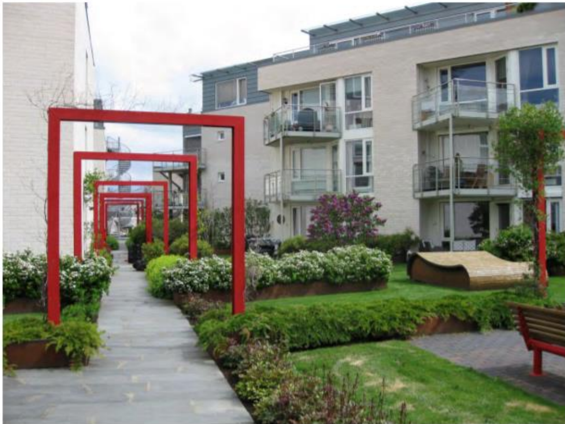
Figur 2: Eksempel på intensivt grønt tak med varierende vekstlagstykkelse i forhold til behovene til beplantningen. Foto: SINTEF Byggforsk (Noreng, et al., 2012)
