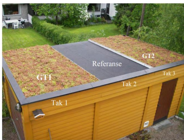
Figur 8: Nylagt grønt sedumtak på garasjetak, 2009. Taknummerering er gitt (Braskerud, 2014)
