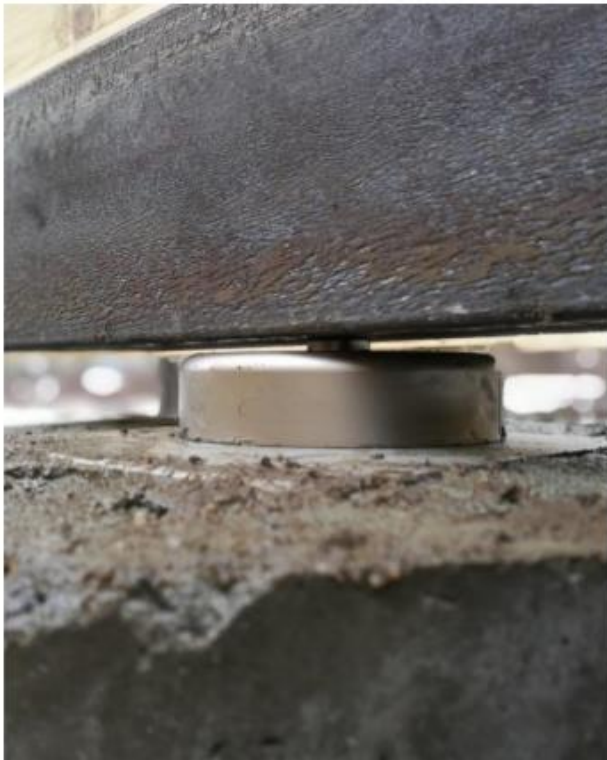
Figur 20: Veicelle plassert mellom fundamentsøyen og hovedbjelken (Øyre & Trommald, 2018)
