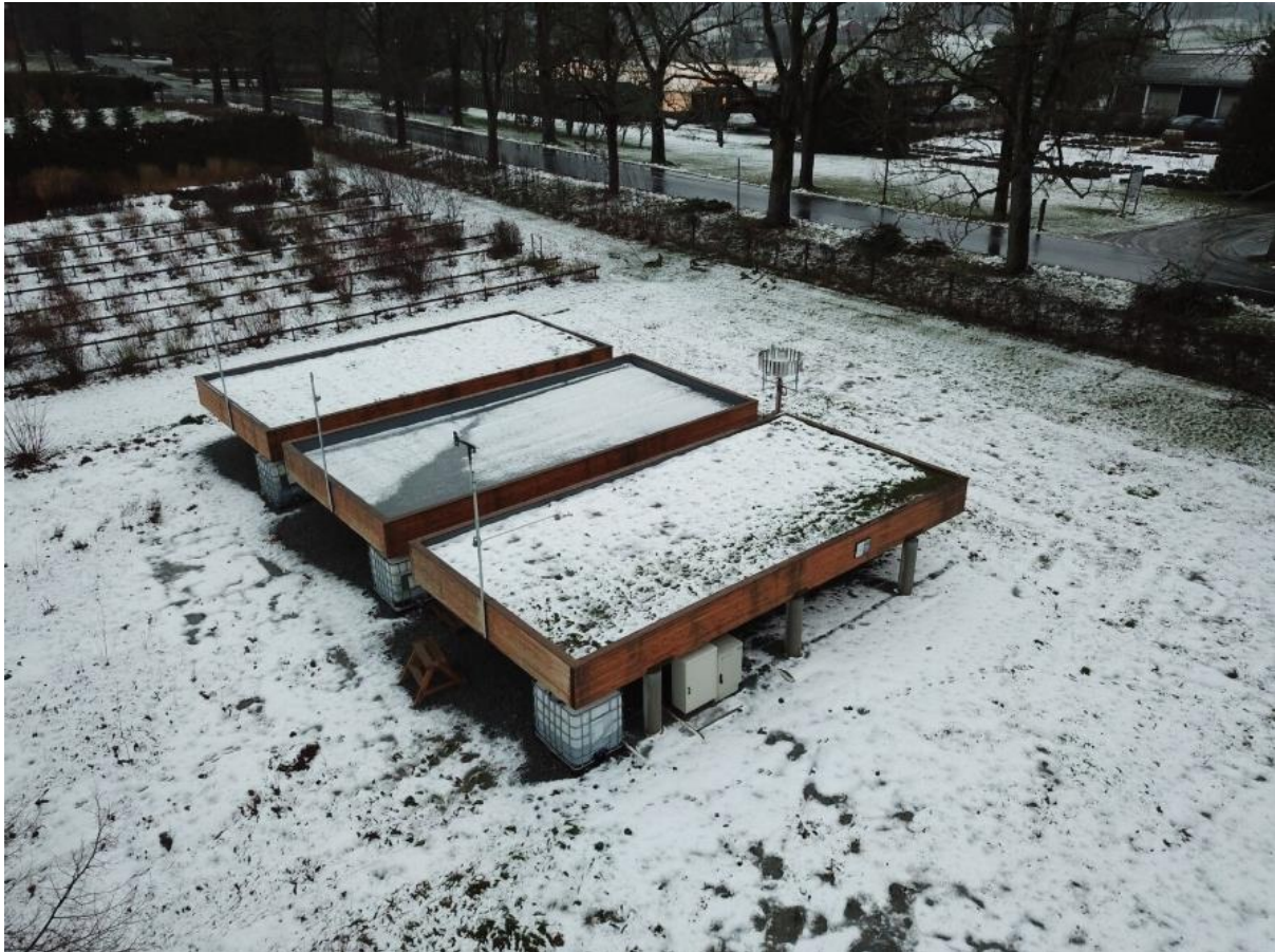
Figur 24: Forskningsstrukturen sett nordøst den 29.11.2018(Knut Magne Møen, NVE)
