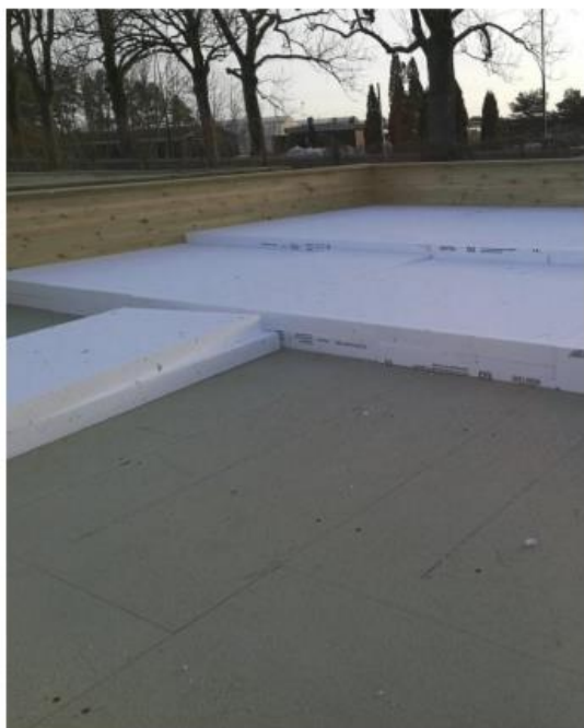
Figur 18: Isolasjonsplater for falloppbygging. (Øyre & Trommald, 2018)
