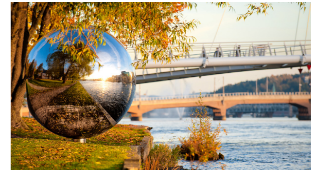
Fig. 32 Elvepromenaden i Drammen fremmer Drammenselva som en kvalitet i byen. Promenaden ligger lavt i terrenget slik at kontakten mellom gangveien og elven opprettholdes. (Drammen.no, u.d.)
