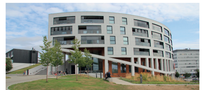
Figur 5.33. Fassade Stadion kjøpesenter.
