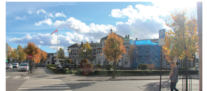
Figur 5.29. Stasjonsparken, med Jernbanebygningen i bakgrunnen.
