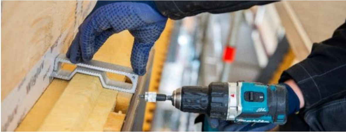
Figur 11 . Elementene blir skrudd på plass (Byggmesteren, 2018).
