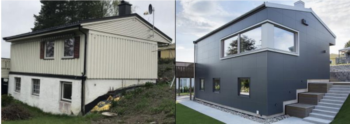
Figur 13. Glava demonstrasjonshus før og etter energieffektivisering (Byggmesteren, 2018).
