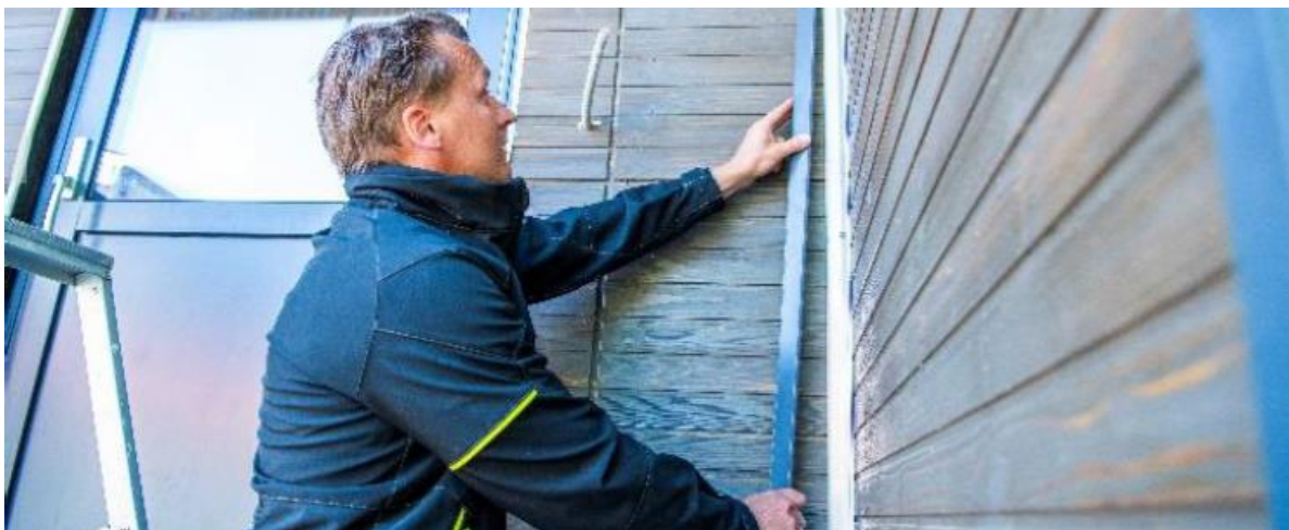
Figur 12. Plassering av aluminiumslist (Byggmesteren, 2018).
