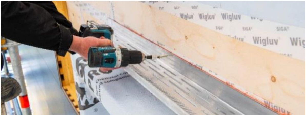
Figur 9. Montering av aluminiumsskinne (Byggmesteren, 2018).
