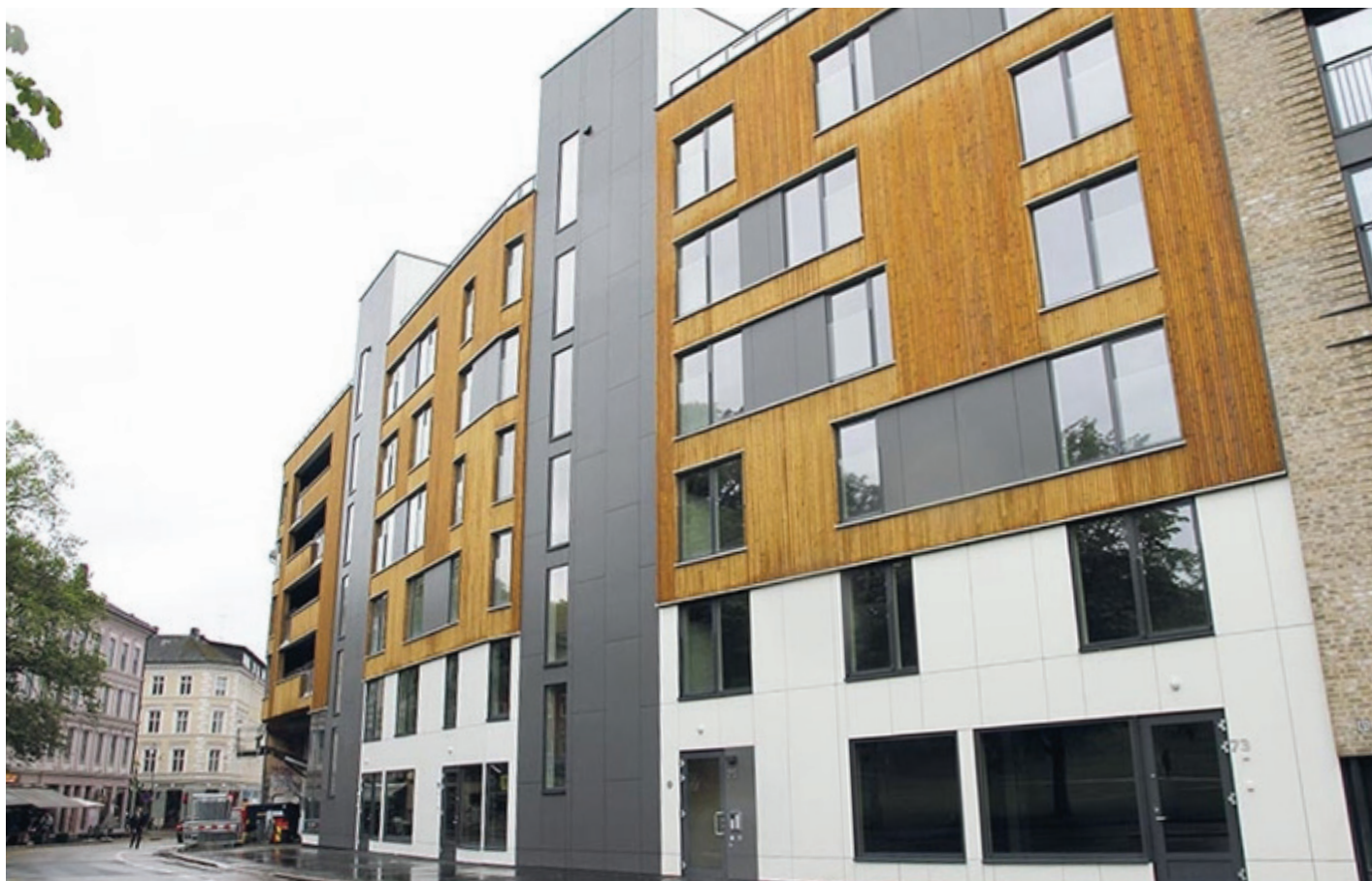
Fig. 28. Grønlandsleiret 73. Foto: Bygg.no
