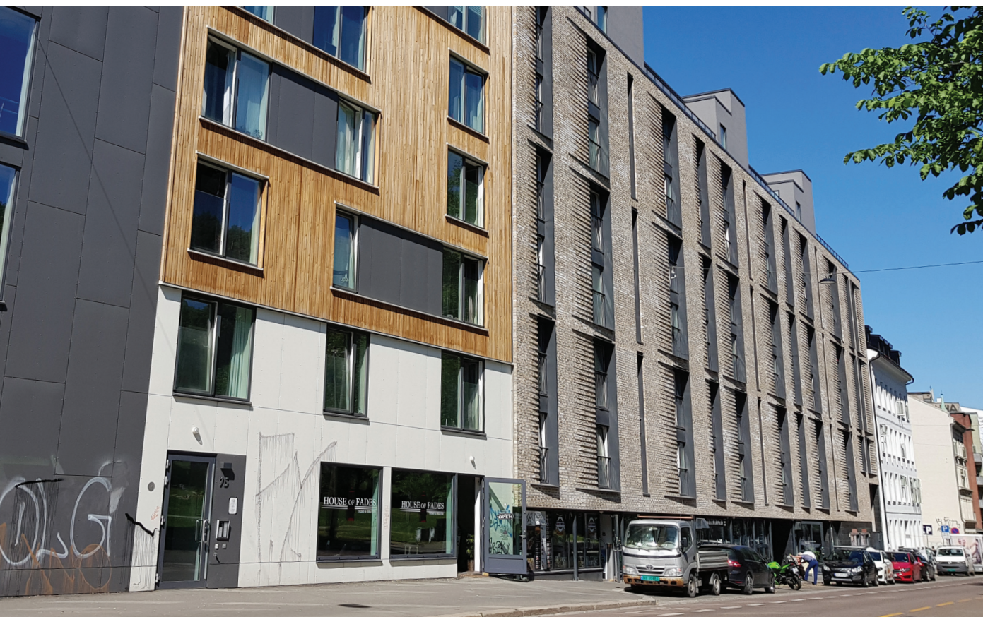
Fig. 29. Grønlandsleiret 73 møter Grønlandsleiret 61. Foto: Vibecke Yrstad
