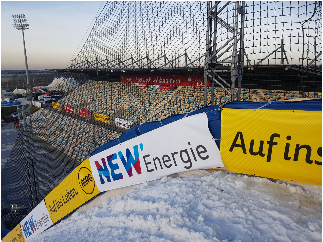
Figur 5.6: Nærbilde av reklameskilt og master. Når bakken ikke bøyer seg er det et presist punkt som er overgang mellom gult og hvitt reklameskilt. I bøyen er det mer upresist, og disse punktene ble vanskelig å bruke. I mastene ser vi at det er mange stenger som går på kryss og tvers. Det er derfor ulikt hvor godt disse punktene er synlig fra siden.
