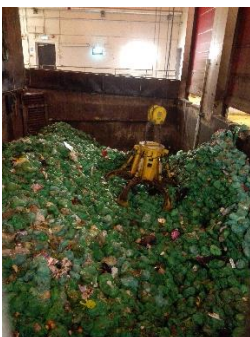
Figur 1. Ankomsthallen for matavfall ved Romerike biogassanlegg.
