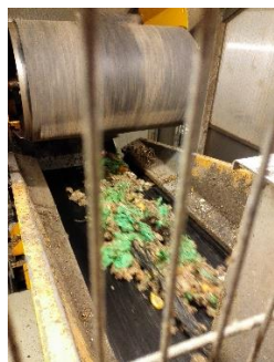
Figur 2. Separasjon av metaller fra biomasse ved Romerike biogassanlegg.
