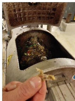
Figur 3. Separasjon av fremmedlegemer ved bruk av skrupresse ved Romerike biogassanlegg.
