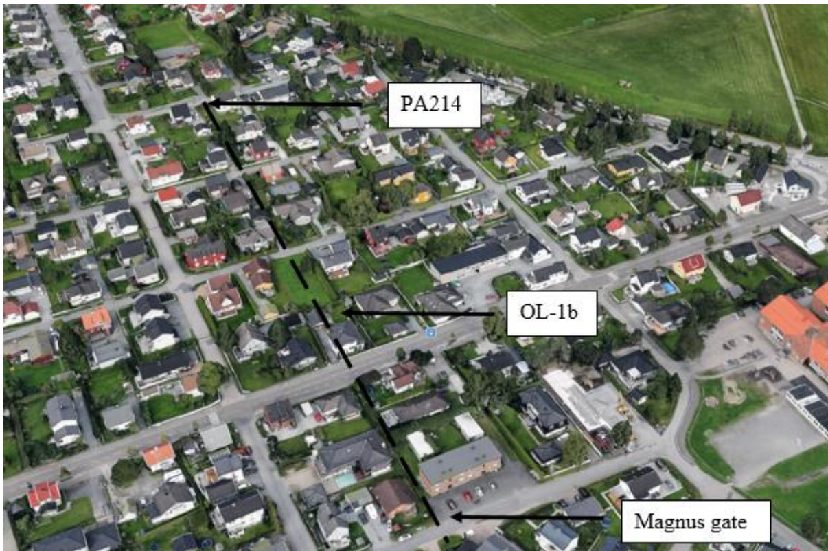
Figur 18: Ledningstrekk: PA214 - Magnus gate (OL-1b) (Google, 2018)
