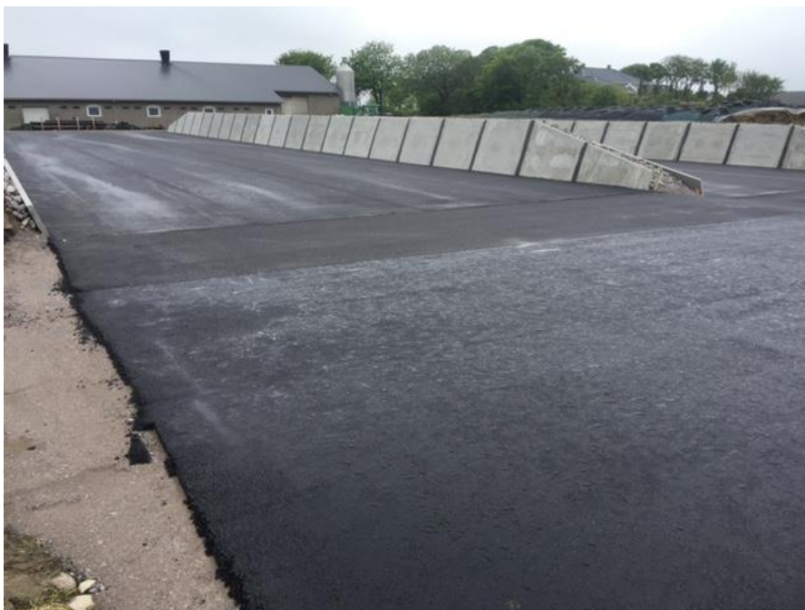
Figur 3. Plansiloer med skråvegger og gjennomkjøring på Jæren. Gulv og platting i fremkant av asfalt. Foto: Åsgeir Aasland, Rå Plansilo AS.
