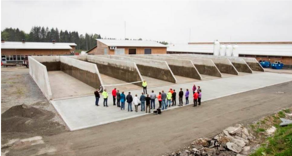
Figur 2. Plansiloer med vertikale vegger uten gjennomkjøring på SHF, NMBU. Gulv og platting i fremkant av betong. Foto: Håkon Sparre, NMBU.
