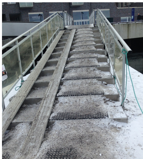
Figur 36: Snø og is i trapper og tampe fra flytebro opp til Sørenga.
