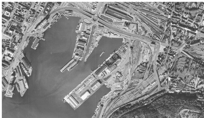
Figur 10: Oversiktsbilde fra 1971. E18 over Bjørvika er bygget.
