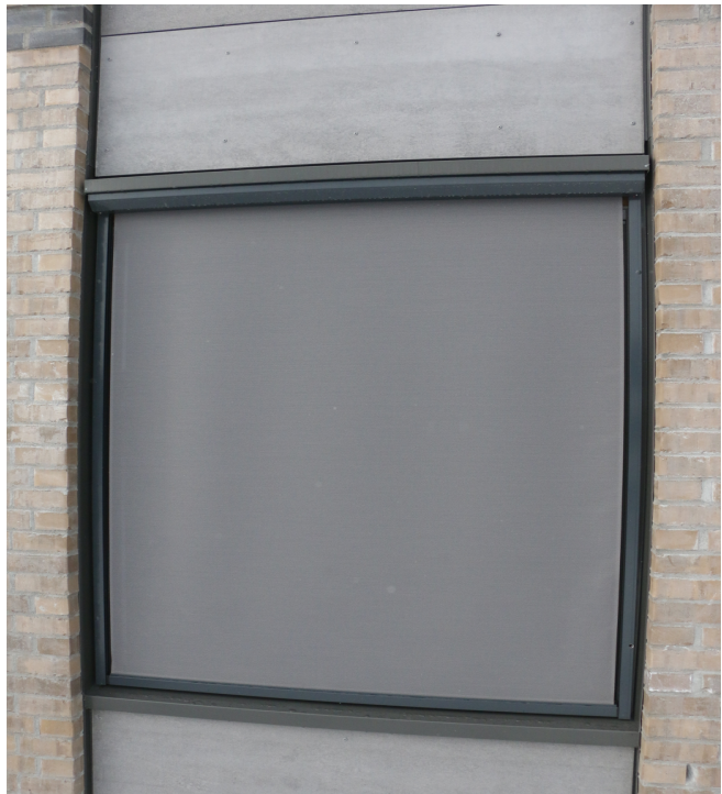
Figur 5 - Screens fra Siggerud Skole. Foto Fredrik Andersen
