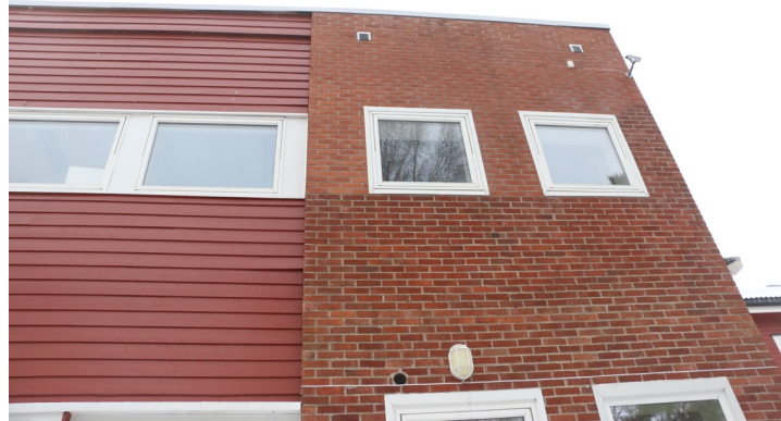
Figur 11 – Vinduene til klasserommet vendt mot nord. Foto Fredrik Andersen
