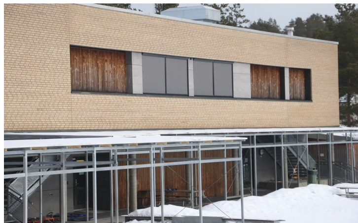
Figur 12 – Vinduene til det sørvendte klasserommet. Her med solskjermingen nede. Foto Fredrik Andersen
