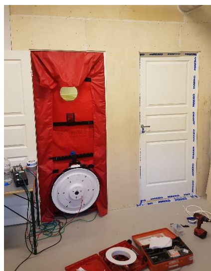
Figur 3.3. Plassering av Blowerdoor (Foto: Georg Thorsnes)
