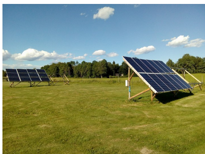
Figur 4.1: Oversikt over de to arrayene med solceller på Sørås-jordet.
