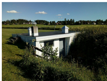
Figur 4.2: Bunkeren der sikringsskapet og sammenkoblingspunktet med distribusjonsnettets finnes.
