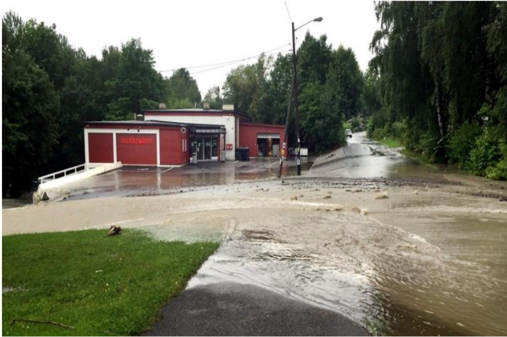
Figur 6. Våkås stasjon i Bærum kommune, ble hardt rammet 06.08.2016
