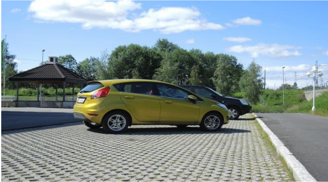
Figur 17. Eksempel på permeable dekke på p-plass ved Fjellhamar
