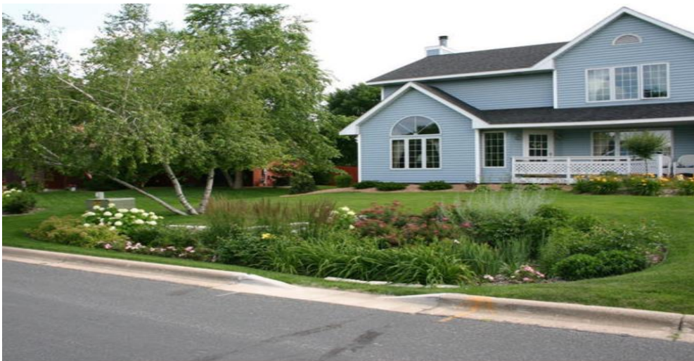
Figur 14. Eksempel på regnbed fra Burnsville i Minnesota i USA
