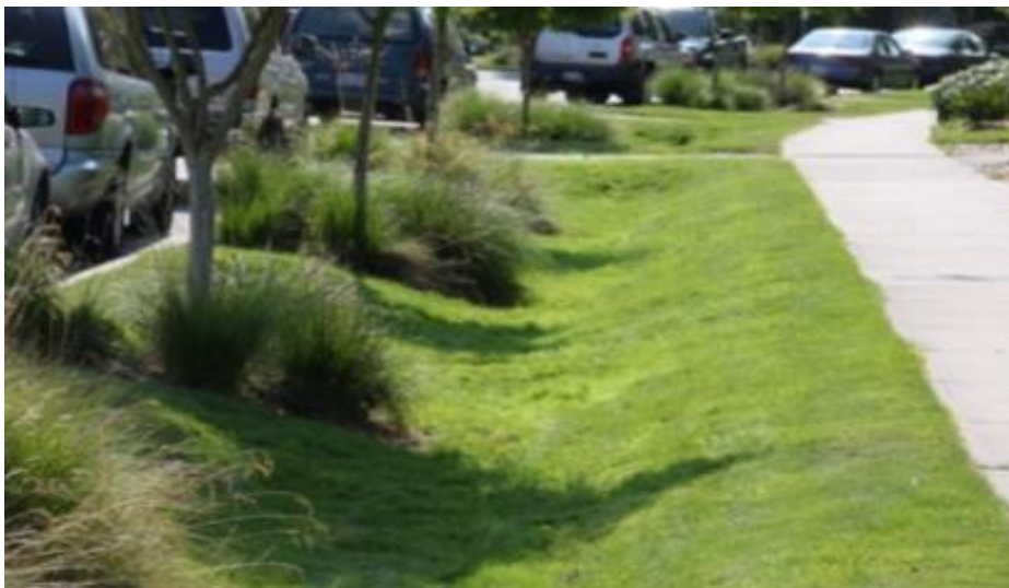
Figur 12. Viser typisk infiltrasjonsgrøft/gresskleddede grøft
