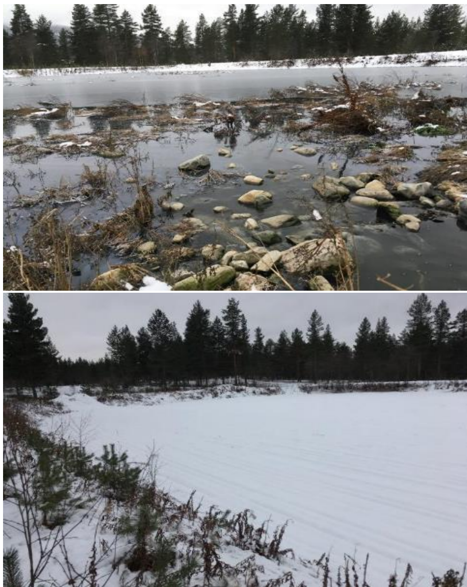
FIGUR 3.12 ØVERST: BASSENG 2 VED KOPPANG RENSEPART I DRIFT. NEDERST: BASSENG 7 I HVILE MED SPOR ETTER HARVING.
