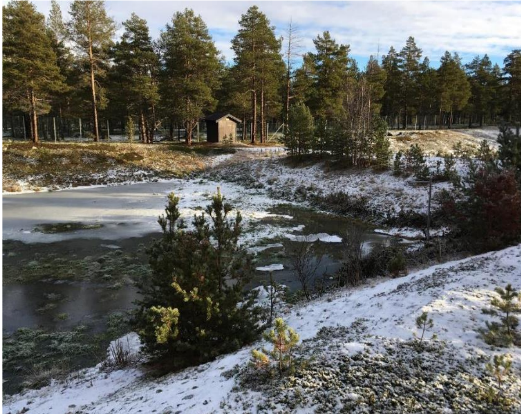
FIGUR 3.5 INFILTRASJONSBASSENG I DRIFT. OPPSTUVINGEN ER LITEN I FORHOLD TIL KANTEN SELV OM BASSENGET HAR STÅTT I DRIFT I 4 ÅR. I BASSENGET ER DET SYNLIG ALGEOPPBLØMSTRING (IMP, NOVEMBER 2016).
