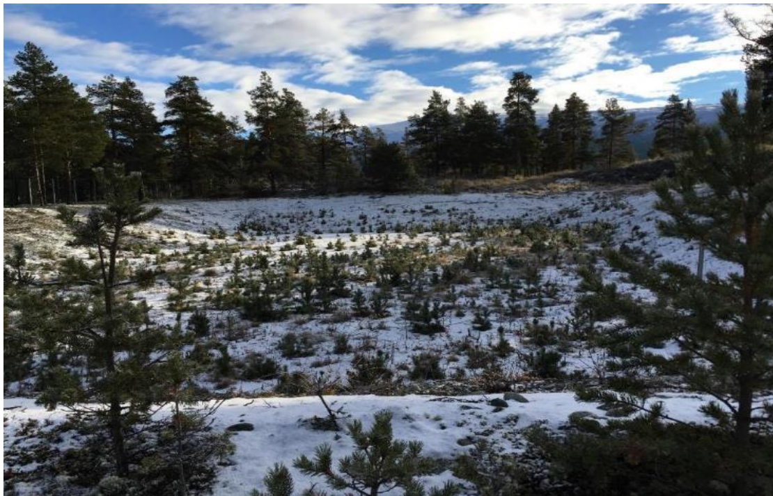
FIGUR 3.4 INFILTRASjonsbasseng i hvile. Filterflaten har begynt å bli tilgrodd av små furu (IMP, November 2016).
