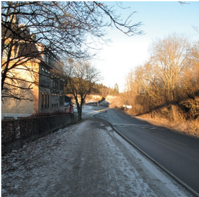
Figur 128: bedre framkommelighet og sikrere fortau når man kommer fra Greverud skole
