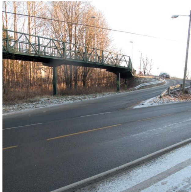
Figur 129: bedre framkommelighet og sikrere fortau når man kommer fra Greverud skole
