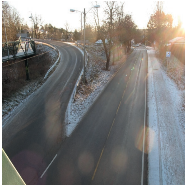
Figur 122: mangel på fortau og farlig kryss (bro over veien ved Oppegård stasjon)''
