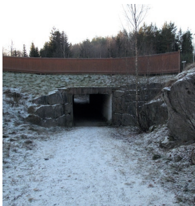
Figur 107: undergang under Tverrveien
