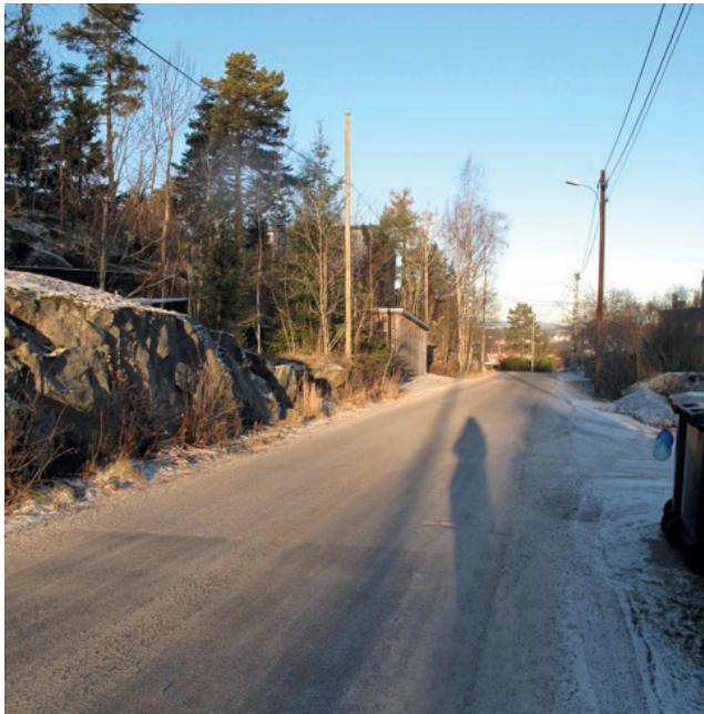
Figur 97: Manglende fotgjengerfelt mellom Bjørnemyrveien ned til Stangåsveien og Byåsveien”
