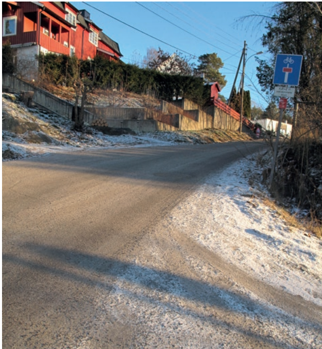
Figur 125: fortau i Slåbråtveien
