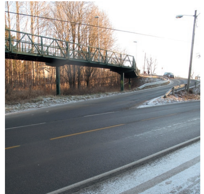
Figur 123: mangel på fortau og farlig kryss (bro over veien ved Oppegård stasjon)''
