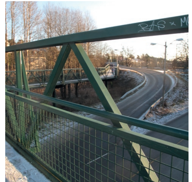
Figur 130: bedre framkommelighet og sikrere fortau når man kommer fra Greverud skole
