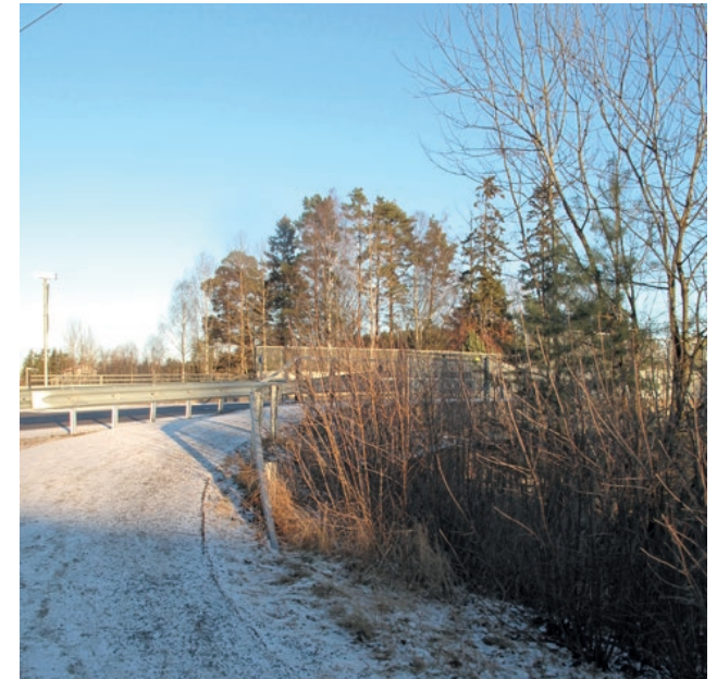
Figur 99: Bro på Myrvoll, tungvint å måtte gå under, tilbake, for så å krysse.”
