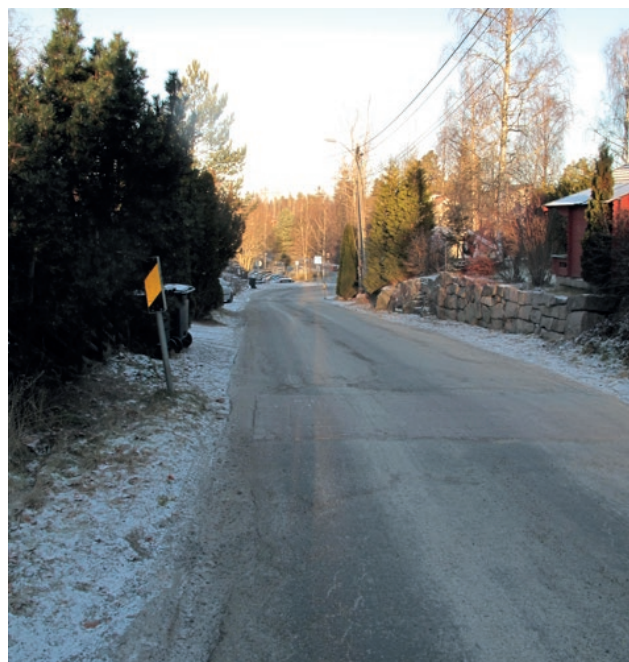
Figur 114: Etablering av fortau i Bakkeveien
