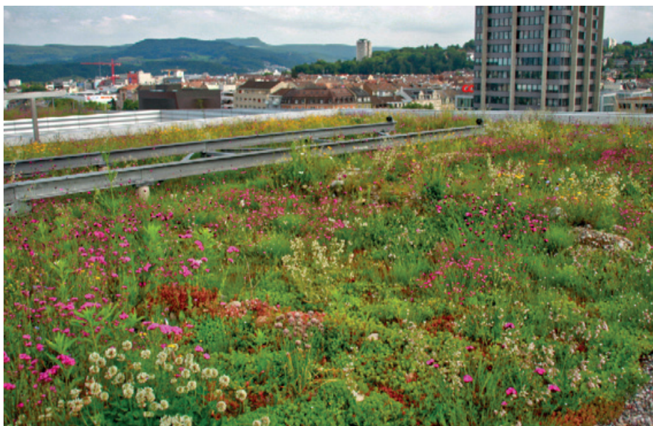
Figur 112: Over ser man hvordan eng på taket kan utvikle seg. Bildet er fra et grønt tak i Basel, Sveits.
