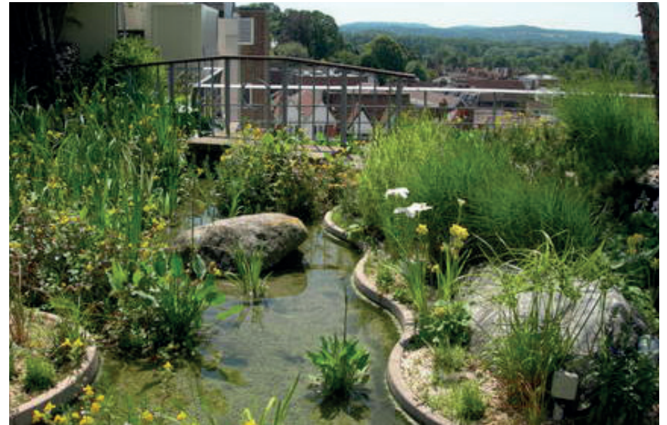
Figur 33: Viser bildet av en dam på et grønt tak.
