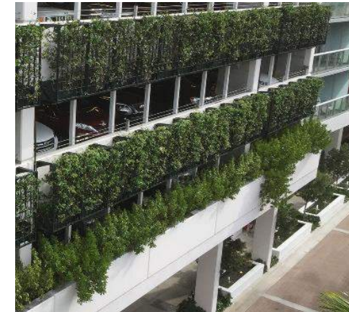
Bilde 3.40 - Garasjeanlegg med Gskys Basic Wall. Foto: Gsky
