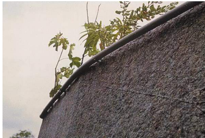
Bilde 3.52 – Blancs filtvegg som viser irrigasjonssystemet. Foto: Patrick Blanc
