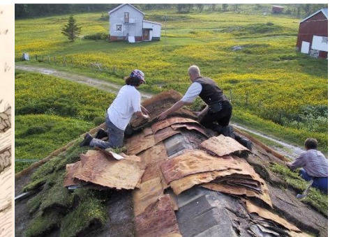
Bilde 3.5 - Montering av torvtak. Foto: Roald Renmælmo
