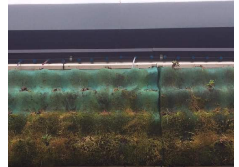
Bilde 3.67 - De blå vannledningene som tilfører næring til hvert plantehull. På befaring til Jekteviken i Bergen (2017). Foto: Knut Feilberg
