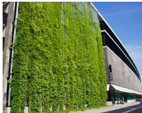
Bilde 3.34 - En grønn vegg med espalier på Sihl City i Zürich, Sveits. Foto: dustygedge.co.uk
