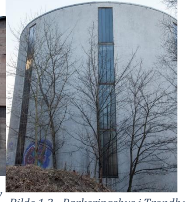
Bilde 1.3 - Parkeringshus i Trondheim. Foto: Stefan Kaliski og Mikkel Marhaug.
