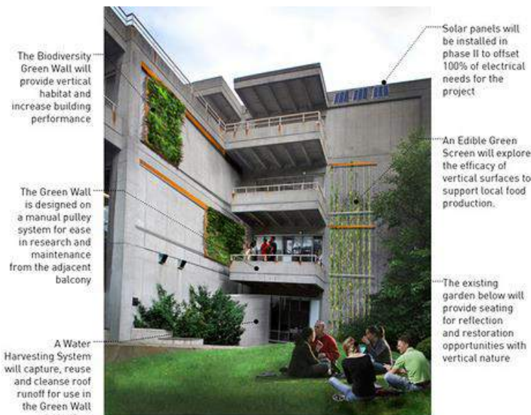
Figur 3.47 - Overvannssystemet til Gould Hall. Figur: Leann Andrews
