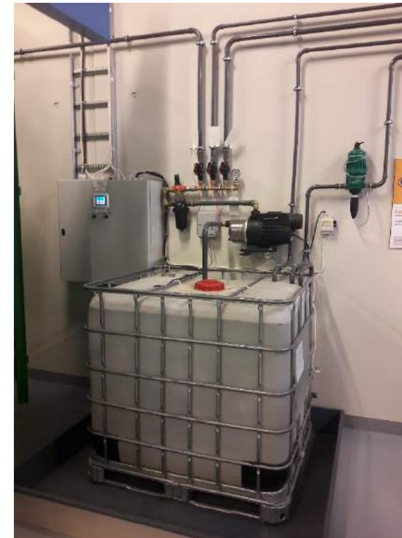
Bilde 3.66 - Dagtanken på 1000 liter som blander vann og næringsstoffer til de grønne veggene i Jekteviken. Foto: Halvdan Rosted (2017)
