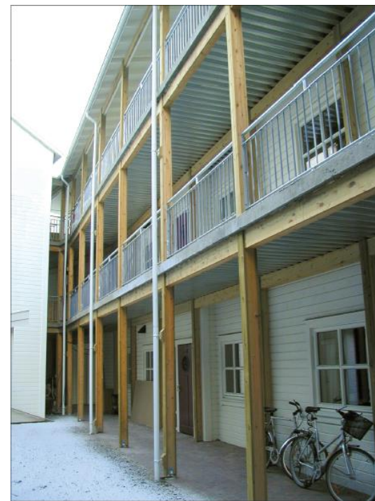
Bilde 3.42 - Svalgang fra byggetalj 526.301
