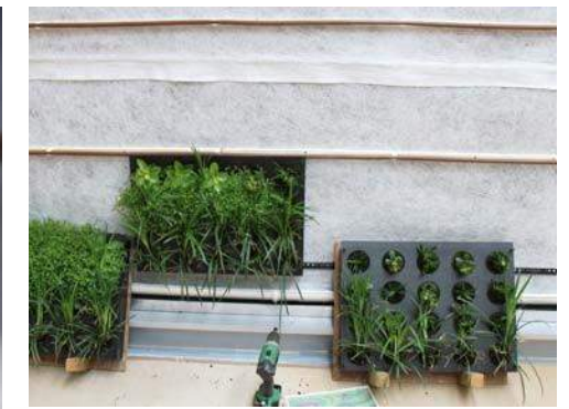
Bilde 3.65 - Monteringen av grønn vegg hos Norsk medisinaldepot. Foto: Arvid Ekle (2011)
