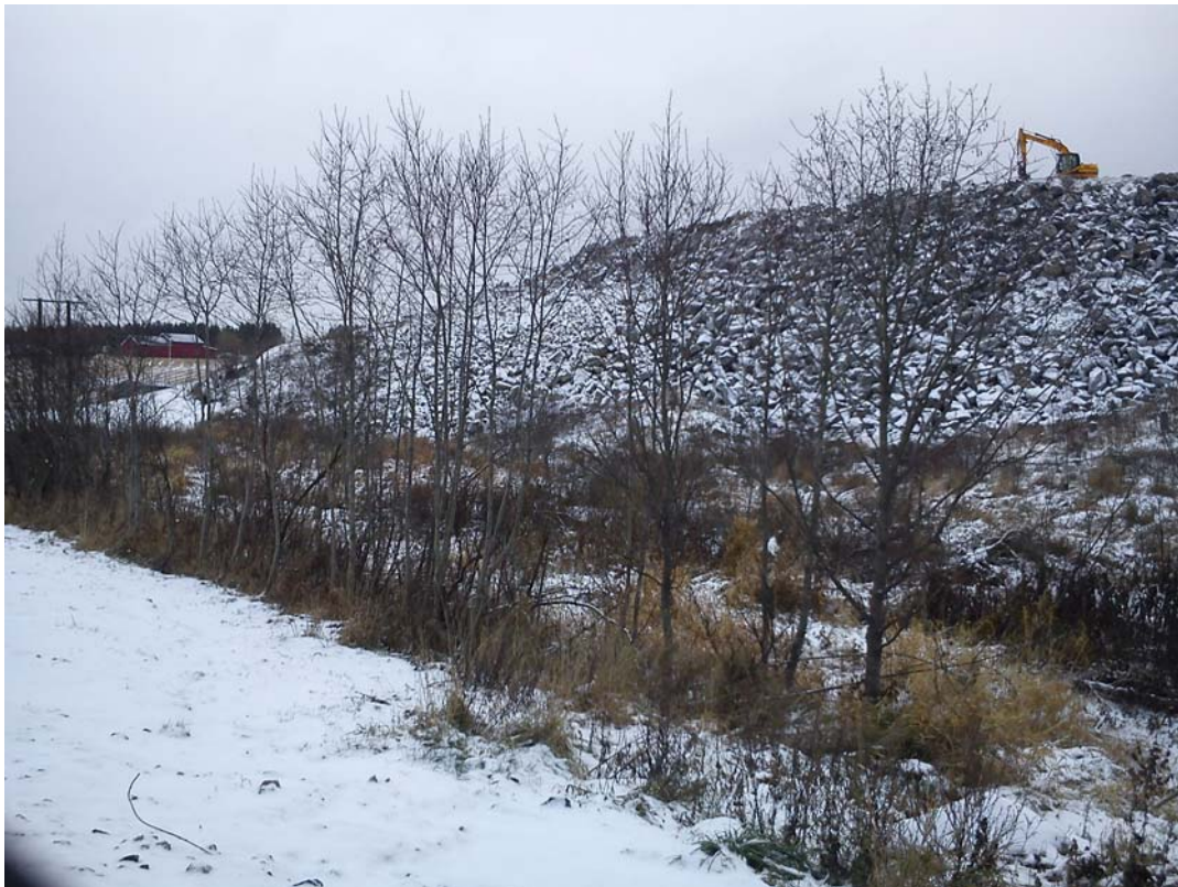
Figur 4.15. Anleggsarbeidene ved Fossbekken hvor 400.000 tonn masse ble deponert langs med bekken. Foto: Karsten Butenschøn, FMOS.
