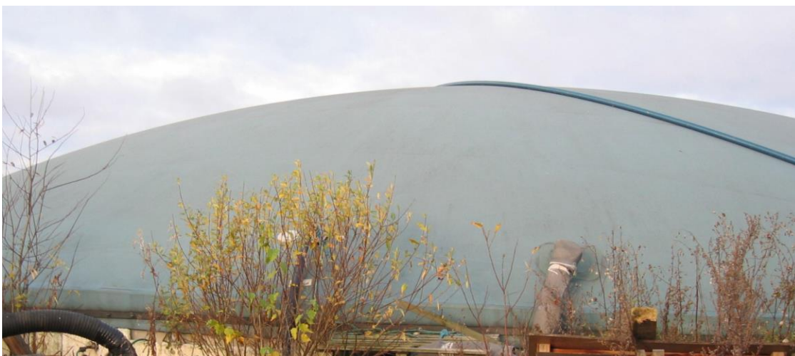
Figur 4. Sluttlager kombinert med gasslager (Foto: John Morken)
