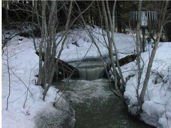
Målestasjonen i Kolstadbekken om vinteren. Det er installert et v-overløp for registrering av vannhøyde.
