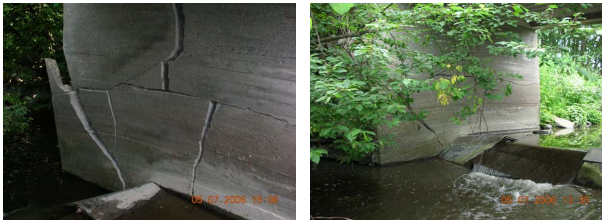
Engstad målestasjon i Hotran. Terskel og brukar i dårlig stand sannsynligvis grunnet frostpåvirkning (Foto: J. Deelstra).
