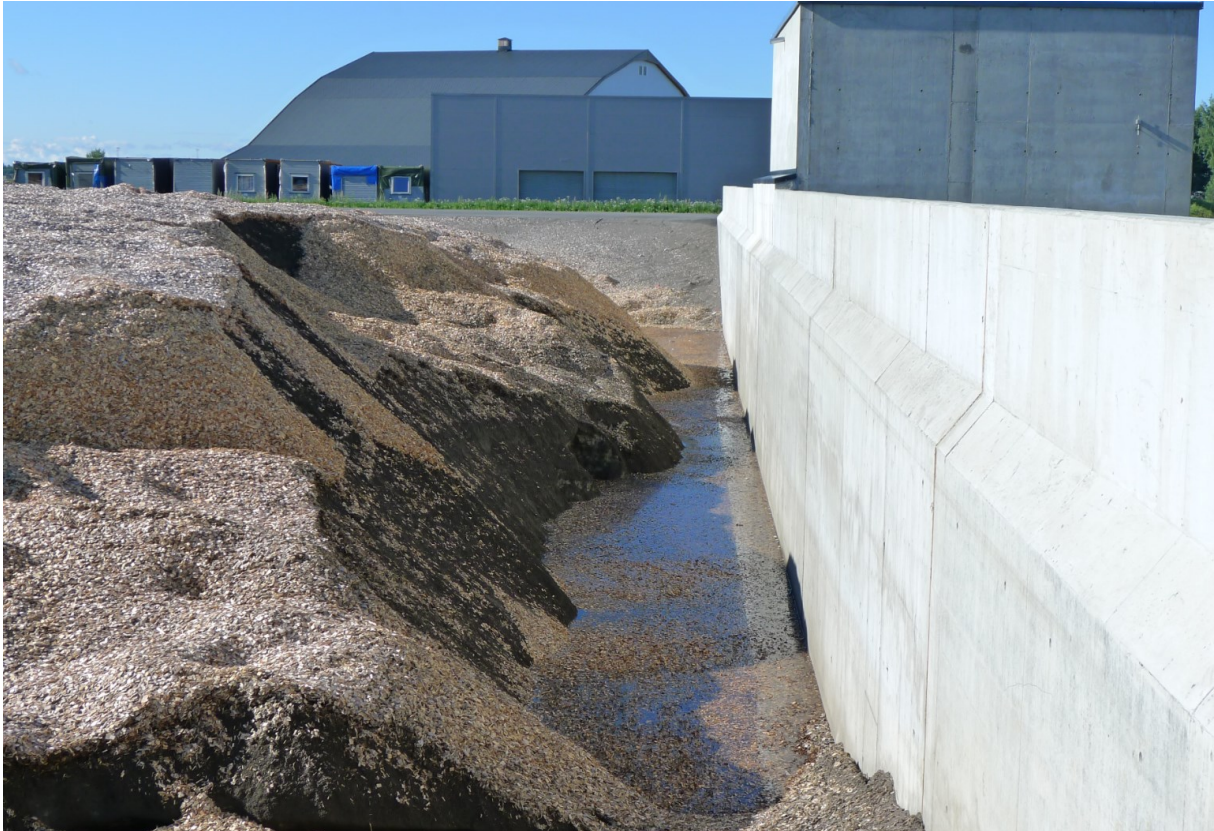
Bilde 6 Innløp til pumpehus under driftsfase
