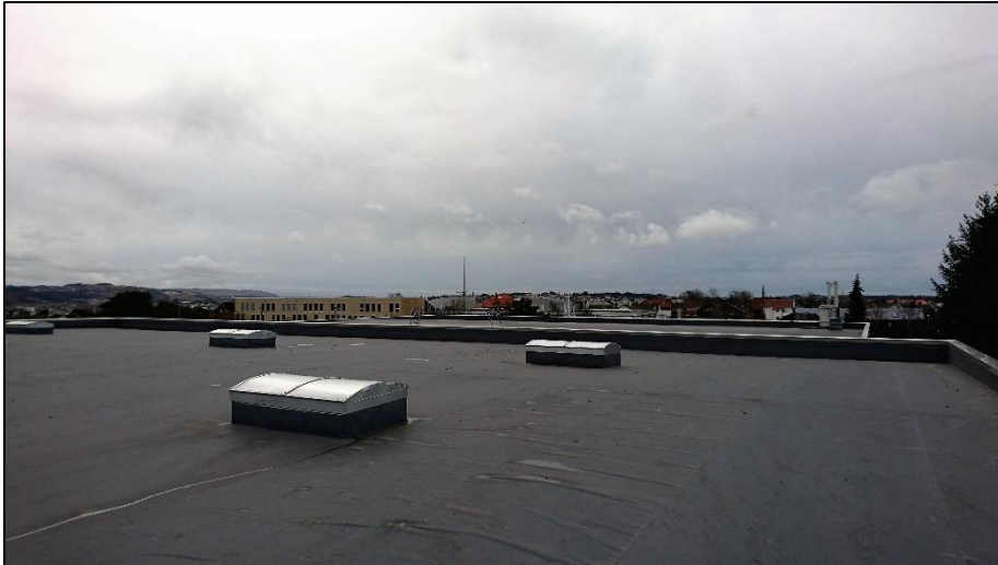
Figur 18: Giskehallen, østre tak i retning sør.
