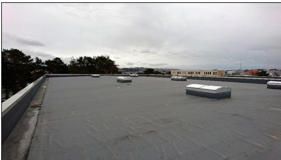
Figur 21: Giskehallen, østre tak. Trærne til venstre i bildet er en skyggekilde.
