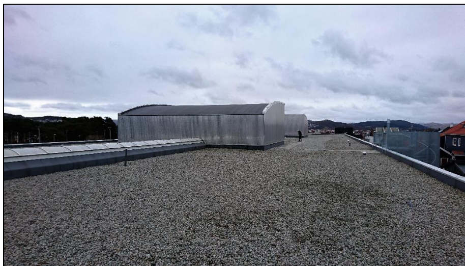
Figur 17: Sandnes vgs, tak og ventilasjonsanlegg med vaktmester til forhold.
