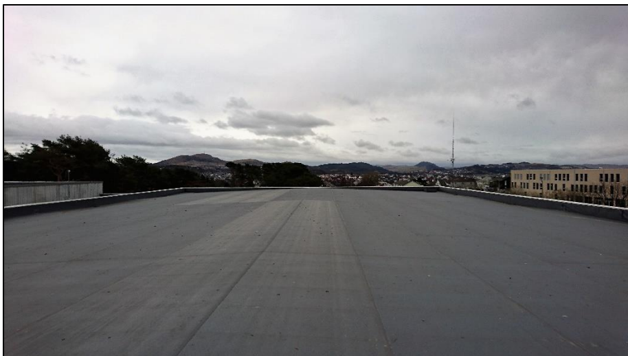
Figur 20: Giskehallen, vestre tak, retning sør-øst. Taket har en svak helning øst-vest.
